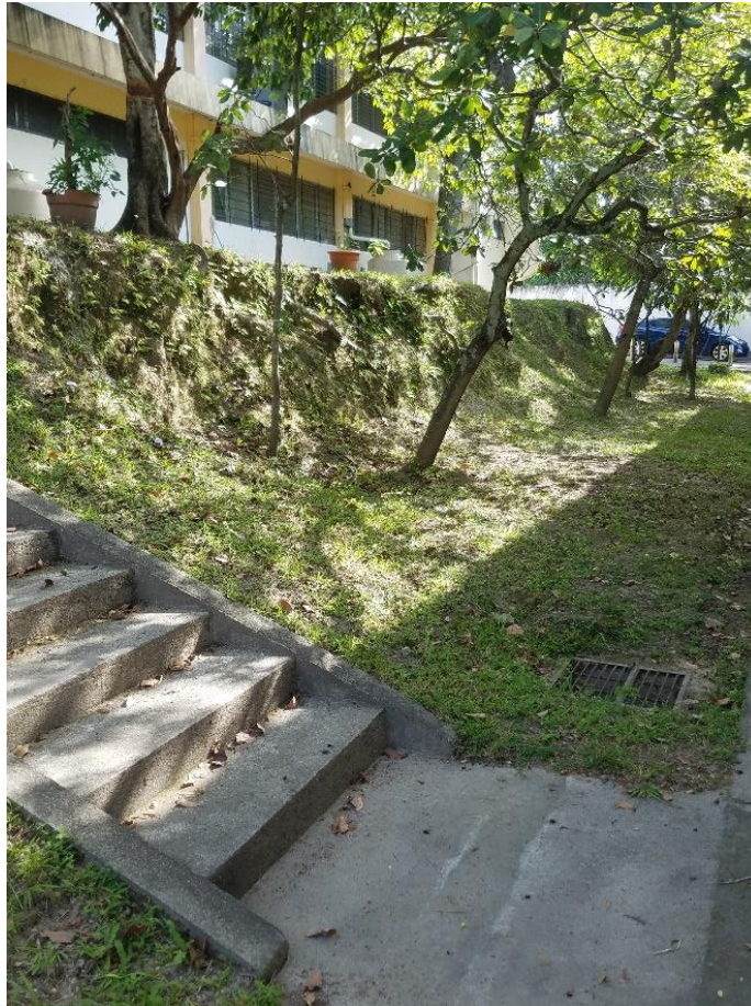
Figura No. 3. 1 Talud ubicado en el costado norte de la Escuela de Ingeniería Civil, Universidad de El Salvador, San Salvador.
