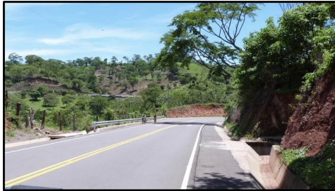
Figura 7: Carretera Longitudinal del Norte, Tramo 3A: By Pass de Chalatenango.
