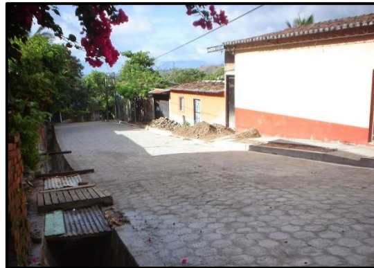
Figura 9: Adoquinado en Calle principal Colonia Las Vegas, Ciudad Arce.
