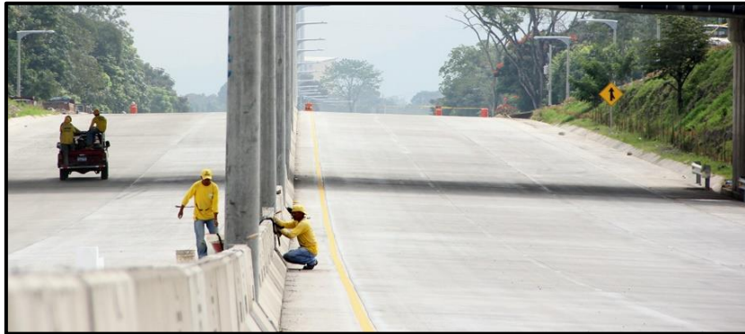
Figura 5: Tramo de Bulevar Monseñor Romero, Pavimento Rígido (Concreto Hidráulico).
