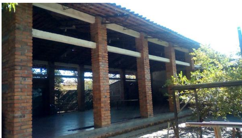
Foto N°4: Vista externa del Salón Parroquial Fuente: Foto tomada por el grupo
