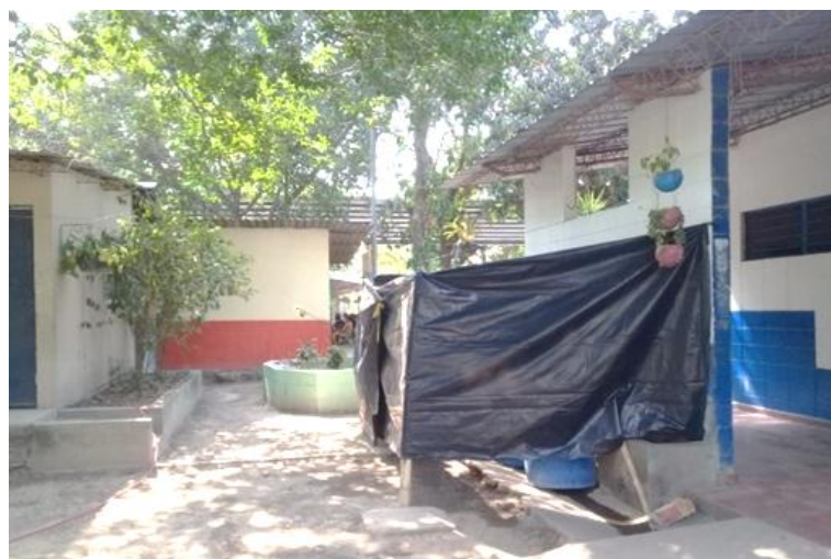
Foto N°7: Baños del Centro Escolar, Retiro Kerigmático año 2019. Fuente: Foto tomada por el grupo
