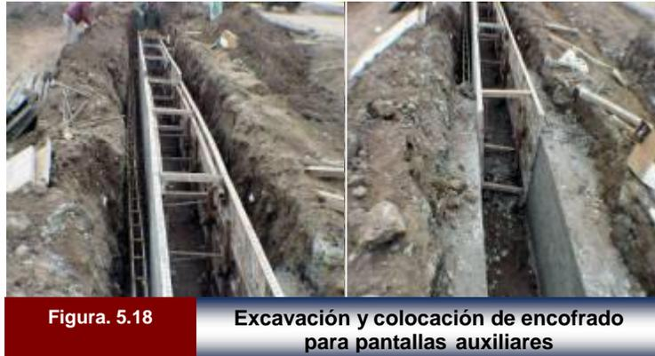
Luego que se han construido las pantallas auxiliares se procede a la excavación de los módulos a la profundidad especificada mediante almejas ver figura 5.19.
