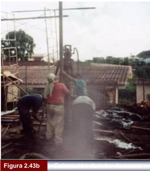
la vaina ingrese al interior del tubo de acero; ésto se explica en el siguiente paso. En la figura 2.43a se muestra los tubos de acero (o tubos manguitos) y en la figura 2.43b la instalación de los mismos. Este tubo deberá estar separado del fondo de la excavación para evitar la corrosión del mismo.
