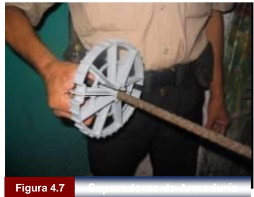
**Figura 4.7** Separadores de Armadura
