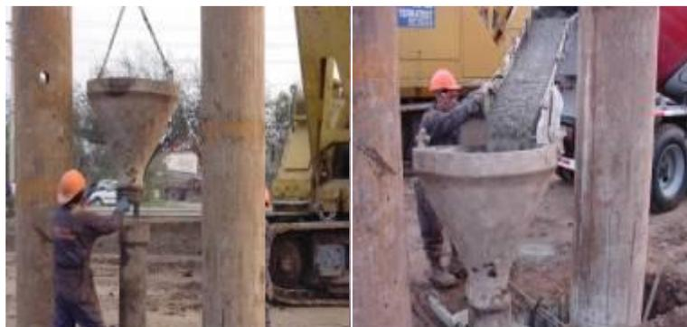
Figura 5.23 Colocación del concreto mediante tubería tremie
