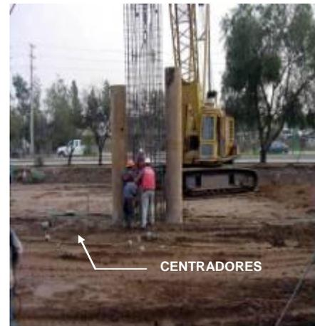
Figura 5.22 CentRADORES de acero de refuerzo
