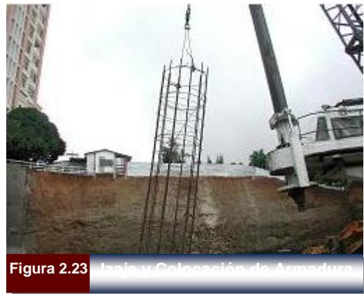
Figura 2.23 Traje y Colocación de Armadura
