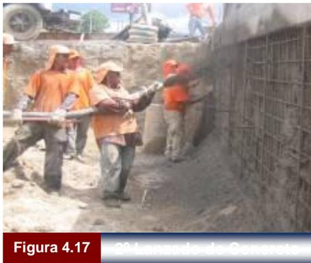
Figura 4.17 Colocación de Concreto
