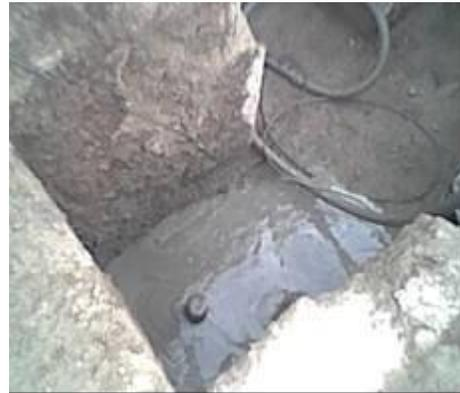
**Figura. 3.31** Micropilote inyectado
