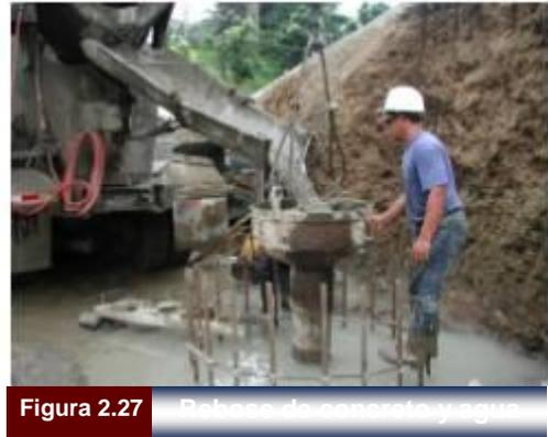
exista en el fondo de la excavación o fluidos encontrados, debido a la diferencia de densidades, ver figura 2.27.
