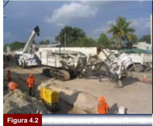
Figura 4.2 Perforadora Soilmec R-12
