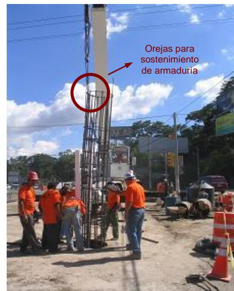
Figura 4.6 Colocación de Armadura
