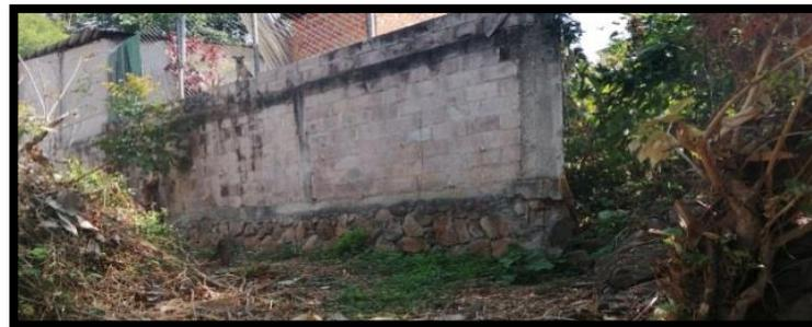
**Fotografía 1.** Muro de Bloque de concreto con base de piedra.
