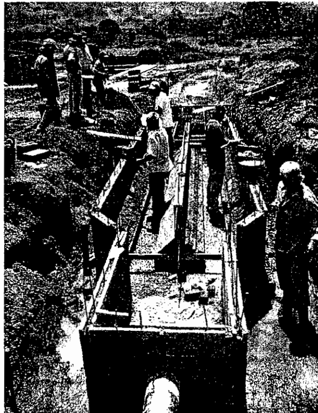
Fotografía mostrando la construcción de un Tratamiento Preliminar (Trampa de sólidos, desarenador, medidor de caudales y trampa de grasas)
