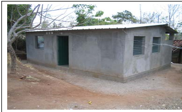
VIVIENDA CONSTRUIDA POR CHF EN EL MUNICIPIO DE ESTANZUELAS.
