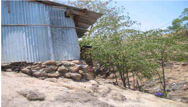
Vivienda ubicada en el barrio San Pablo.
