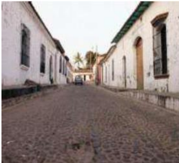
Figura 2.1 Pavimento Empedrado Fuente: Método de diseño de losas de dimensiones superficiales optimizadas en pavimentos de concreto hidráulico.
