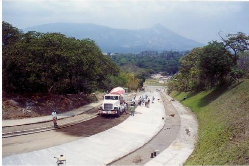
Figura 2.15 Fotografía de la construcción de un Pavimento Rígido Fuente: Manual de procesos Constructivos para Pavimentos de baja intensidad del tráfico de el Salvador utilizando concreto hidráulico simple y emulsiones asfálticas.
