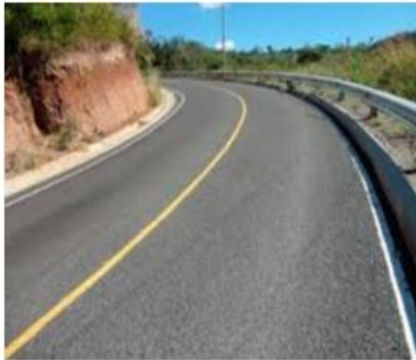
Figura 2.4 Pavimento Asfáltico Carretera Cinquera - Tejutepeque Fuente: Equipos de Construcción S.A de C.V. ECON
