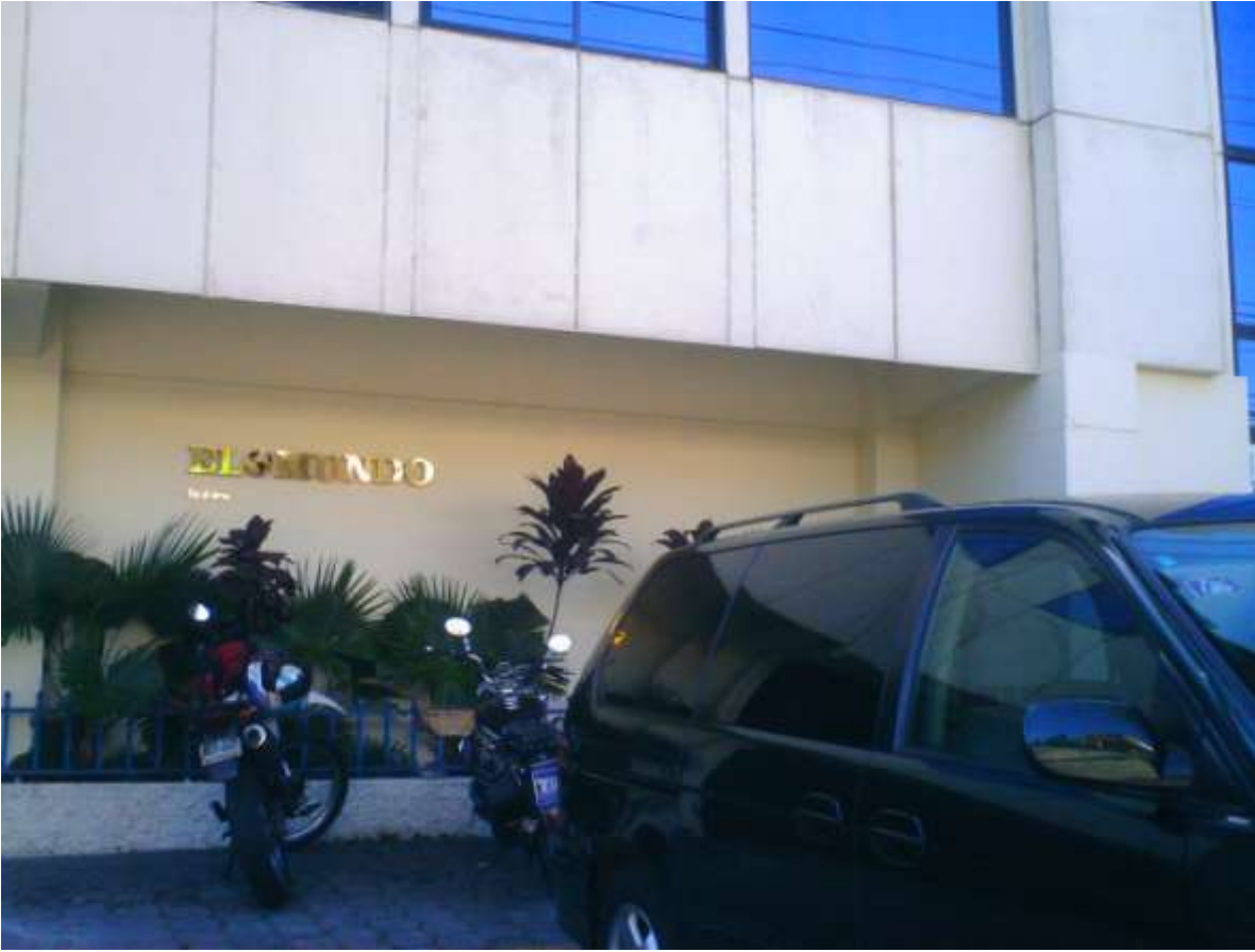
Parte de la fachada edificio Diario El Mundo
