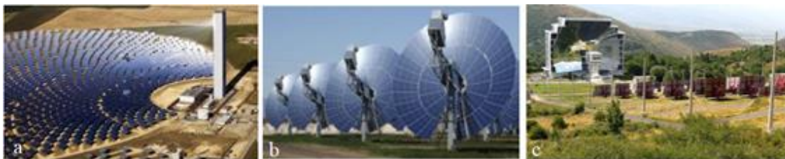
Figura 30. a) Fresnel central de torre. b) Fresnel de discos parabólicos. c) Horno solar de Odeillo.
