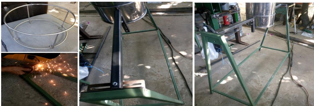
Figura 86. Canasta de soporte del recipiente, soldado de las platinas y montaje de los brazos de soporte sobre la estructura de soporte principal.
