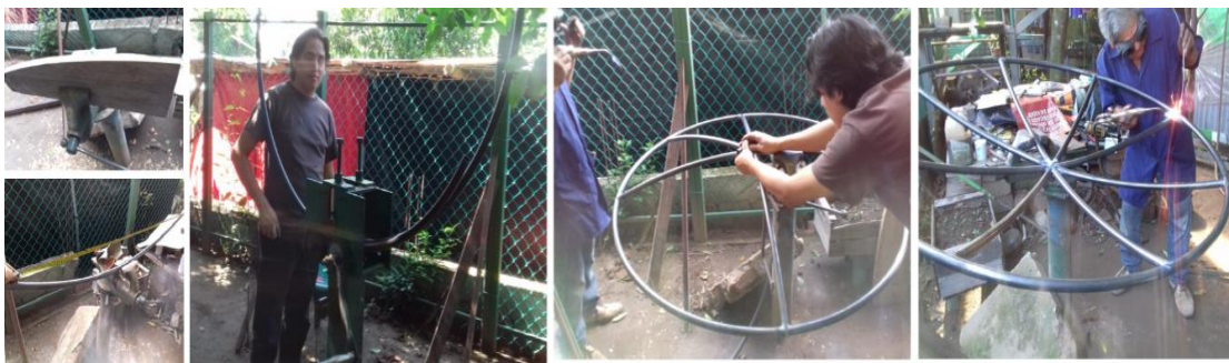
Figura 81. Doblado del aro, y unión de los brazos mediante soldadura.
