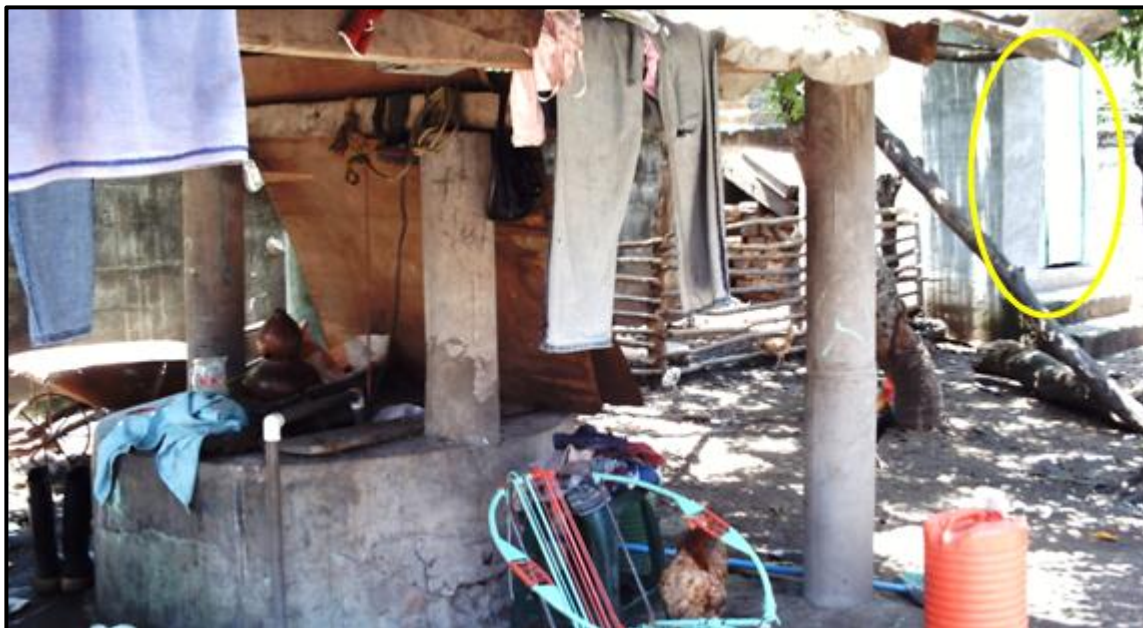
Figura N° 25. Distancia no adecuada entre la letrina y el pozo
