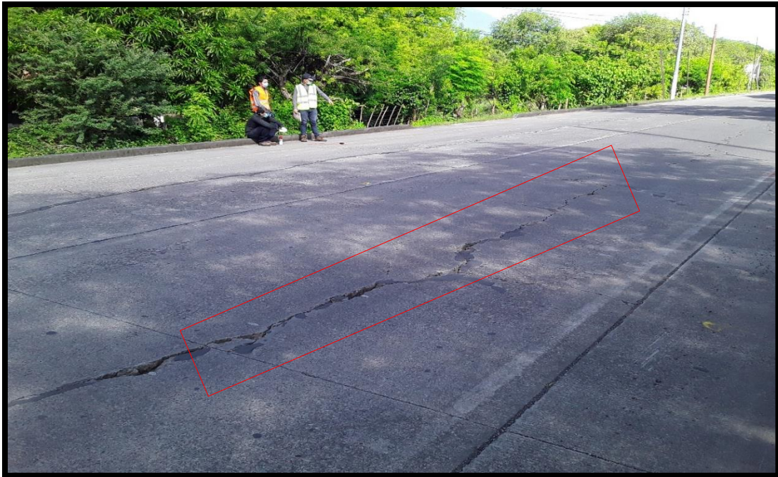
Figura 120: 4.36 Grieta lineal
