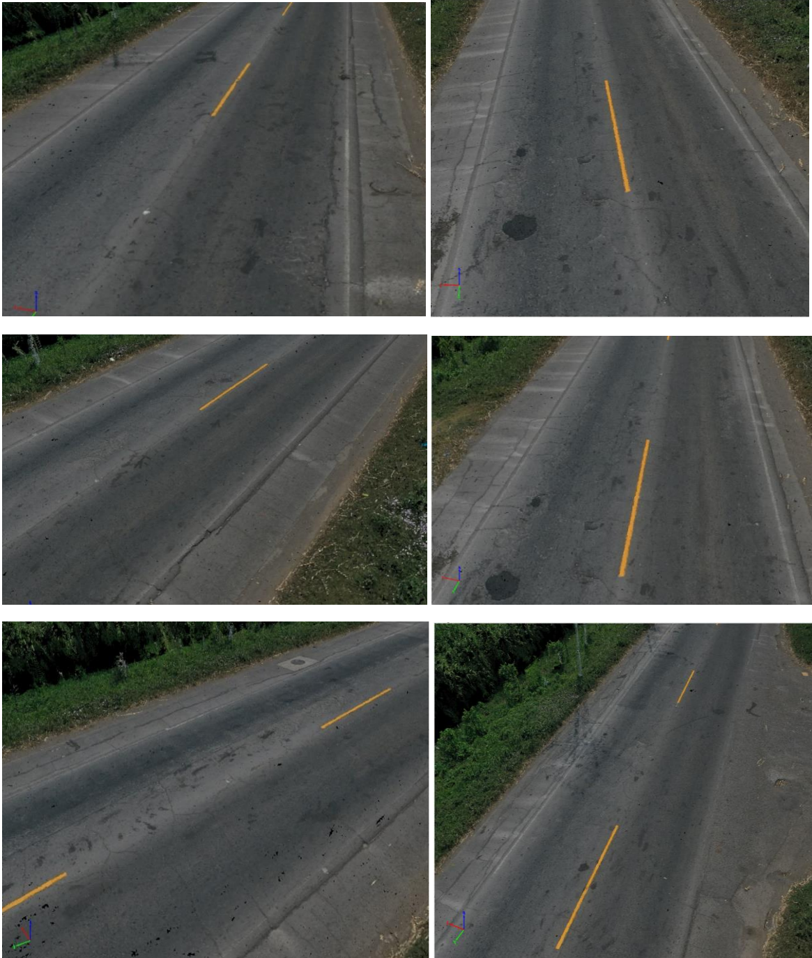
Figura 56: 3.43 Inspección de la vía de pavimento flexible en el modelo 3D
