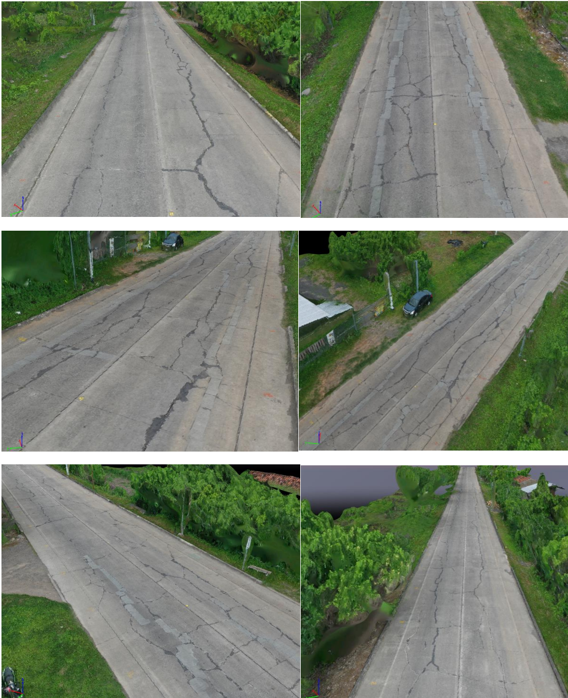
Figura 97: 4.13 Inspección de la vía de pavimento rígido en el modelo 3D
