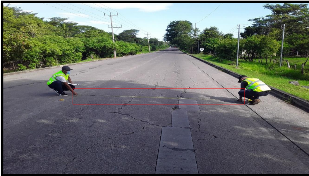
Figura 116: 4.32 Medición de ancho de losa
