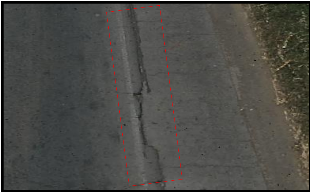
Figura 61: 3.48 Desnivel carril/berma
