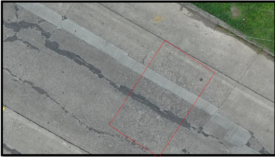
Figura 103: 4.19 Pulimento de agregados
