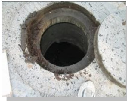
Fotografía No 16 Pozo de Aguas Lluvias.
