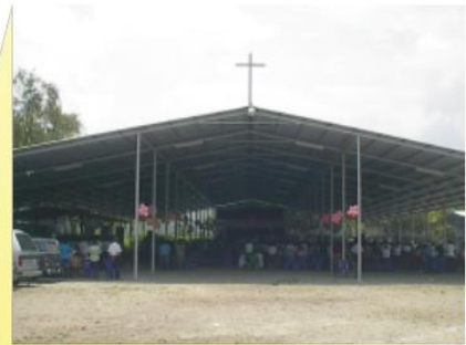
Galera No 1 Fotografía N°6
