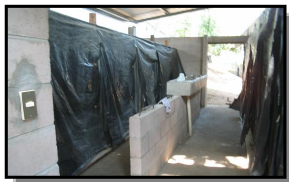
Fotografía N°12 Servicios Sanitarios Mujeres
