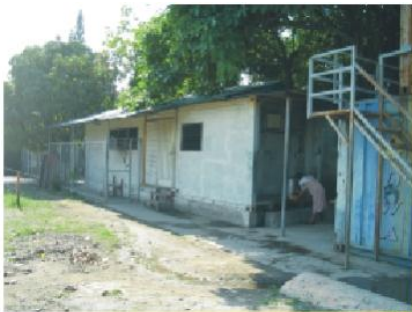
Oficina Administrativa Fotografía N°5
