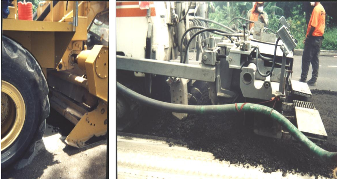
Fig. 7.18 Proceso de escarificado y mezclado
