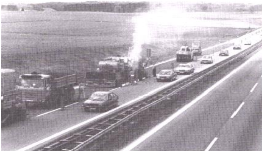
Figura 7.37 Un sitio progresando continuamente en una carretera rápida – el control del tráfico es por una barrera de postes.
