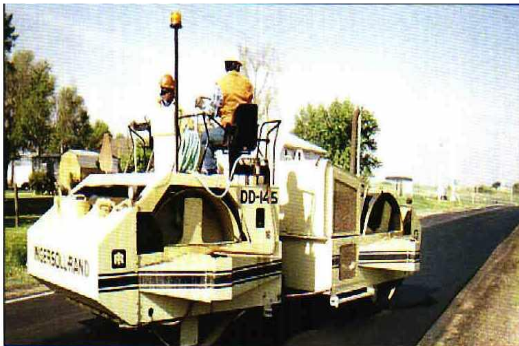
Figura 7.57 Compactación final de la capa de desgaste reciclada
