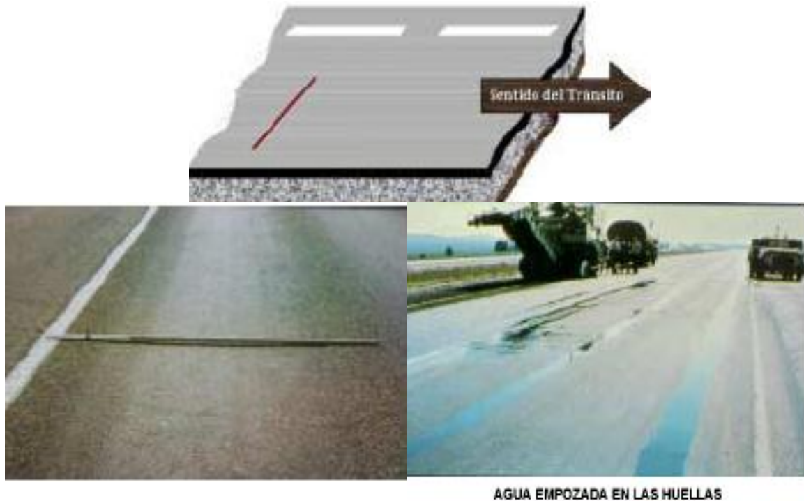
Fig. 3.7 Daño por ahuellamiento
