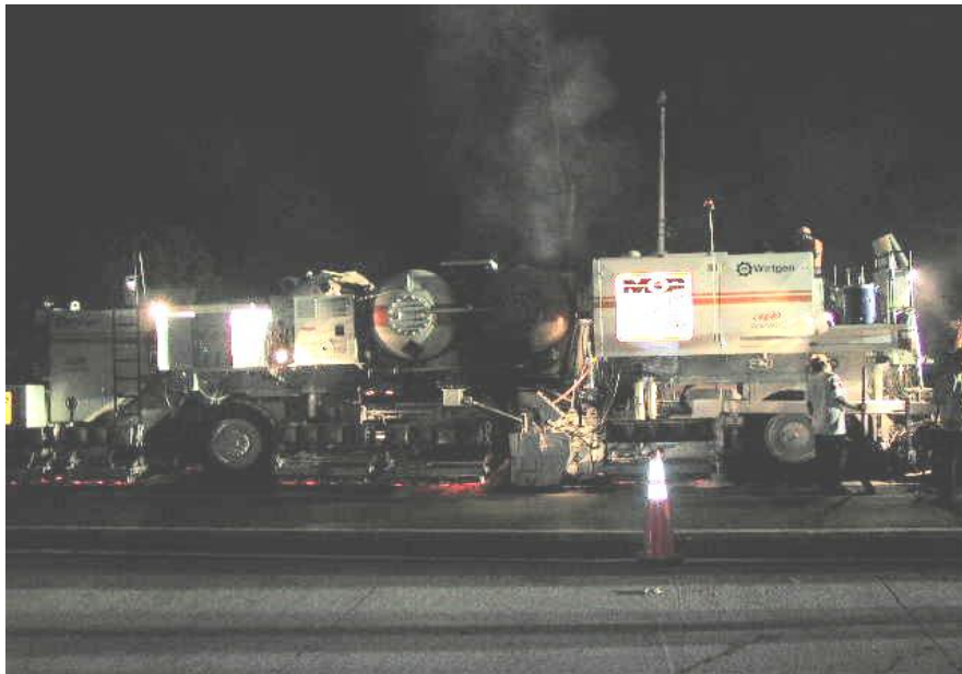
Figura 7.44 Bancos calentadores de la Remixer. Por ser de noche se logran ver encendidos 64 .
