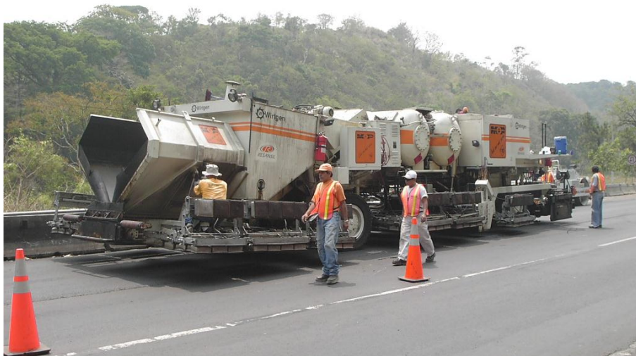
Figura 7.27 Máquina REMIXER 4500 realizando reciclaje en caliente en la carretera hacia Los Chorros 60 .
