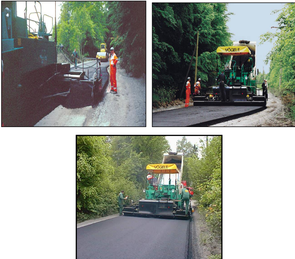
Fig. 7.24 Colocación de carpeta asfáltica en caliente
