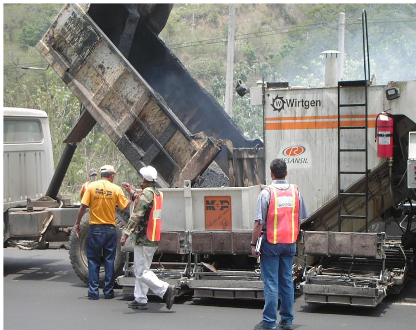
Figura 7.36 Descarga de mezcla adicional en el proyecto de reciclaje en carretera Los Chorros 62 .
