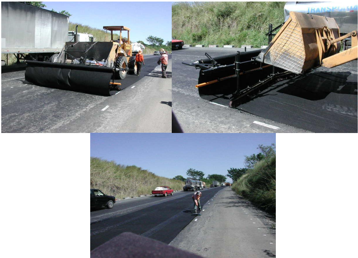
Fig. 7.26 Colocación de geotextil 58
