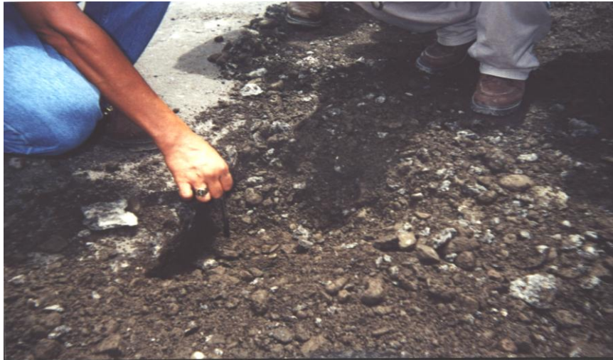
Fig. 7.19 Verificando el espesor escarificado
