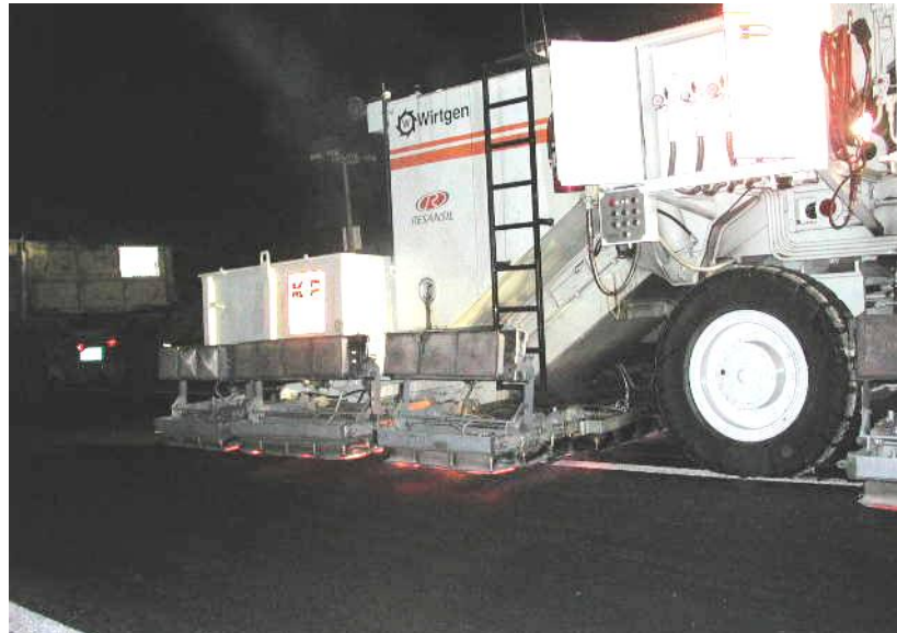
Figura 7.40 Muestra el calentamiento final de la superficie del pavimento realizado en el reciclaje de la carretera hacia Los Chorros 63 .
