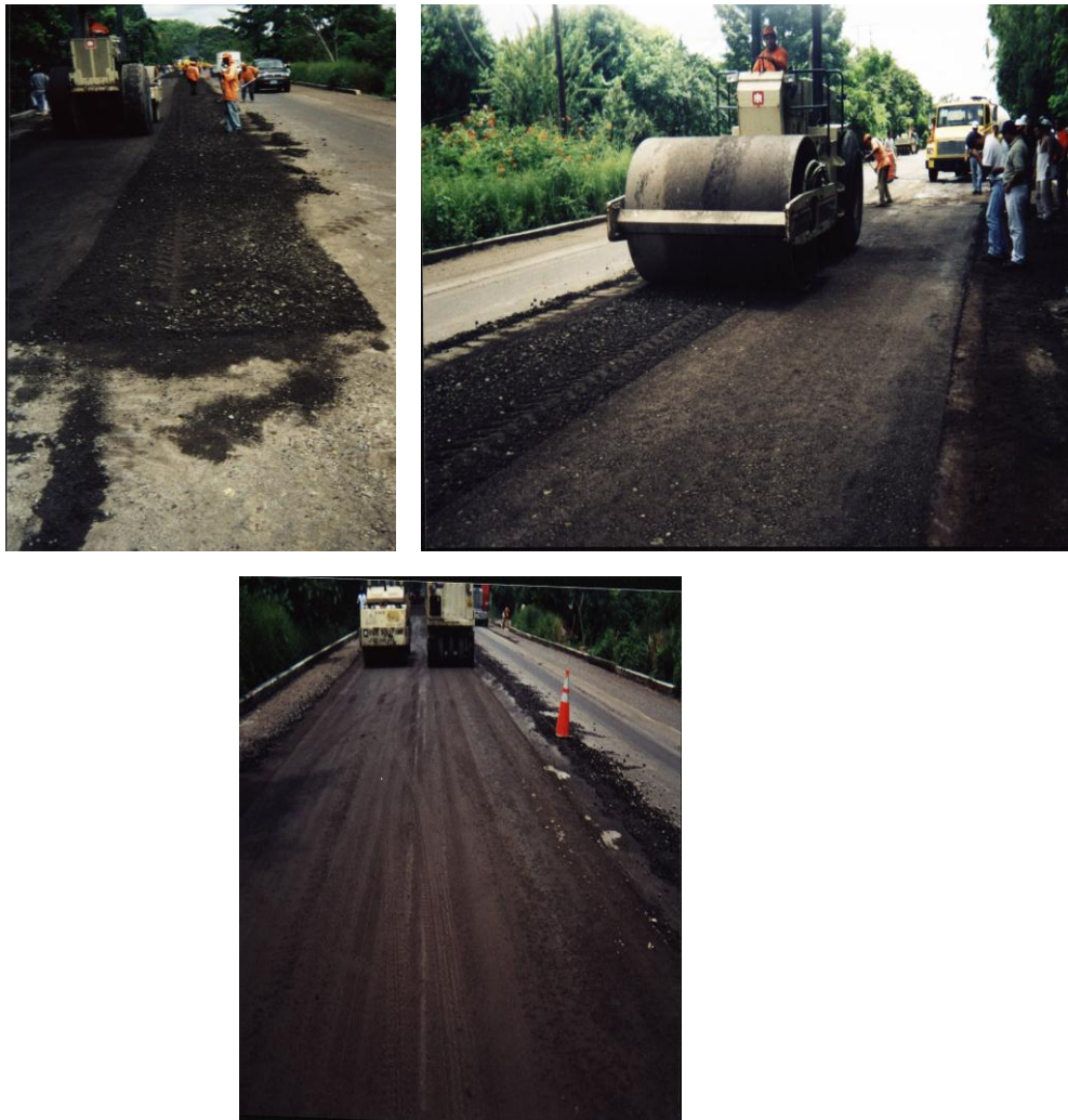
Fig. 7. 22 Compactado de la superficie hasta lograr la densidad requerida y un buen acabado en la superficie.
