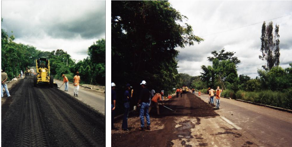
Fig. 7.21 Nivelando la superficie.
