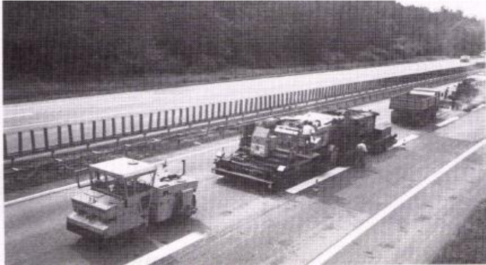
Figura 7.41 Comienzo de operación. El Precalentador ha comenzado a trabajar mientras el camión con la mezcla adicional, el Remixer y el rodillo están esperando, listos para empezar.
