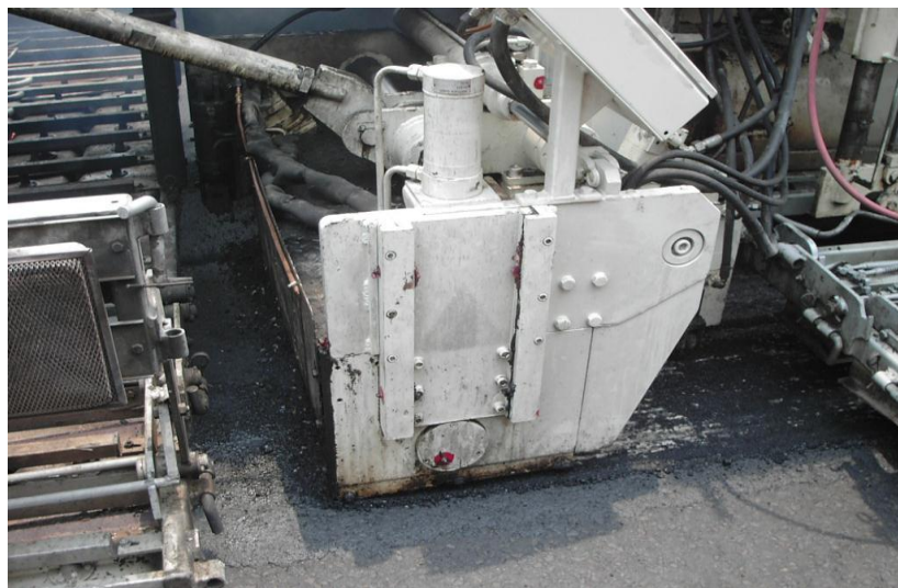
Figura 7.47 Remixer 4500 realizando la escarificación del pavimento en la carretera hacia Los Chorros.
