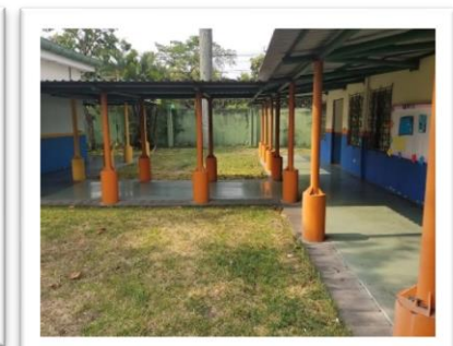
Fotografía 5: Columnas metálicas simbolizando delimitación según su color naranja
