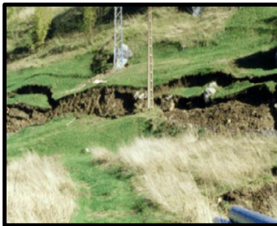
Figura 65. Inestabilidades del terreno.
