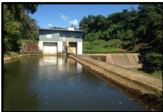
Figura 13. Desarenador, PCH Cucumacayán.
