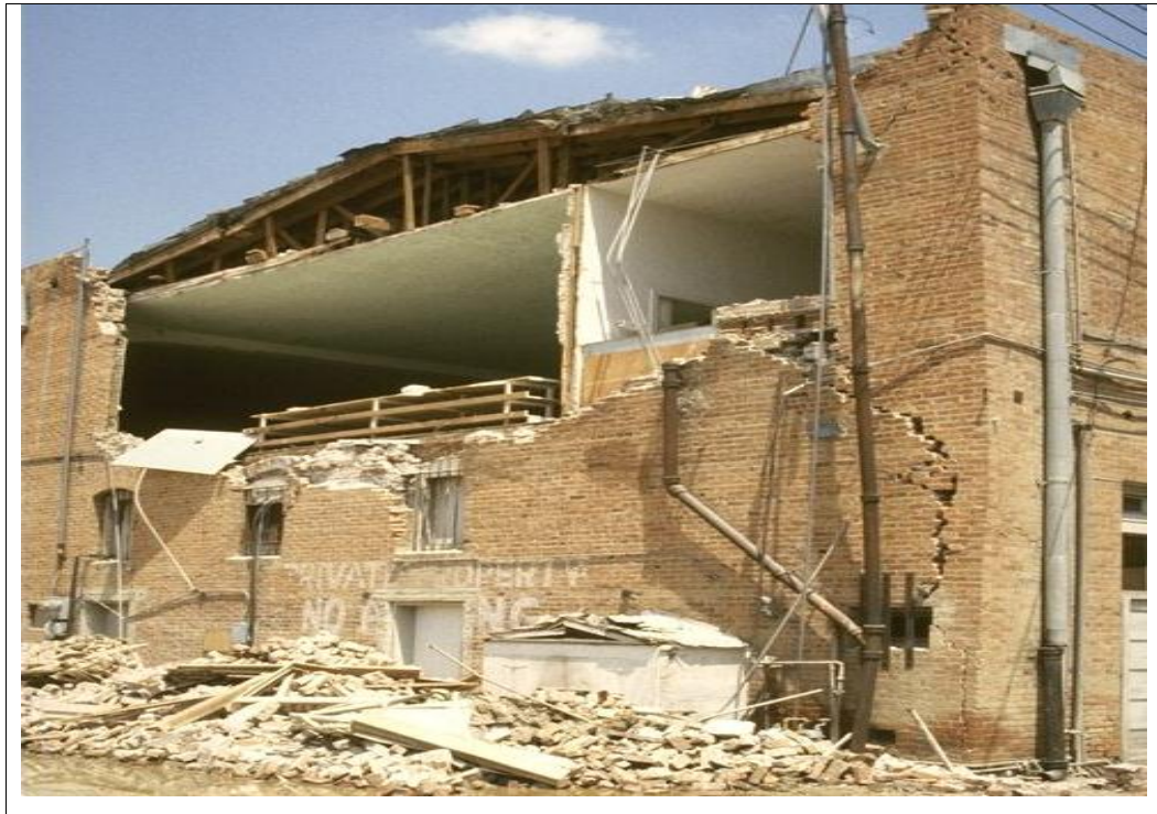
Fig. 2. 67 Caída de una pared de fachada (y parapeto en la parte superior) ( http://www.proteccioncivil.org/pefn/gmartin/gmartin ).
