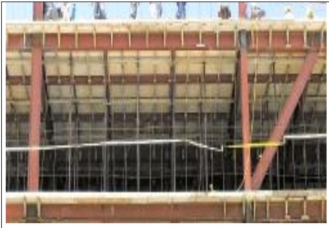
Fig. 2. 4 Sistema estructural de marcos de acero estructural.
