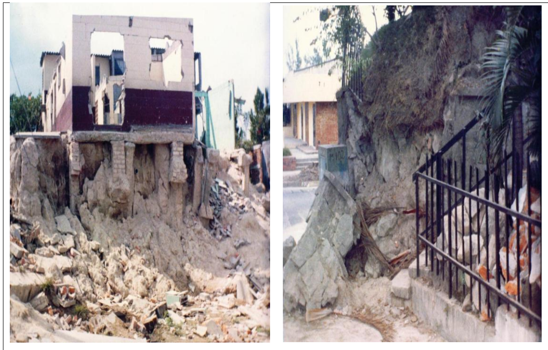
Fig. 2. 93 Deslizamientos producidos por el sismo de 1986 (Avalos C., Juan J., 1987).
