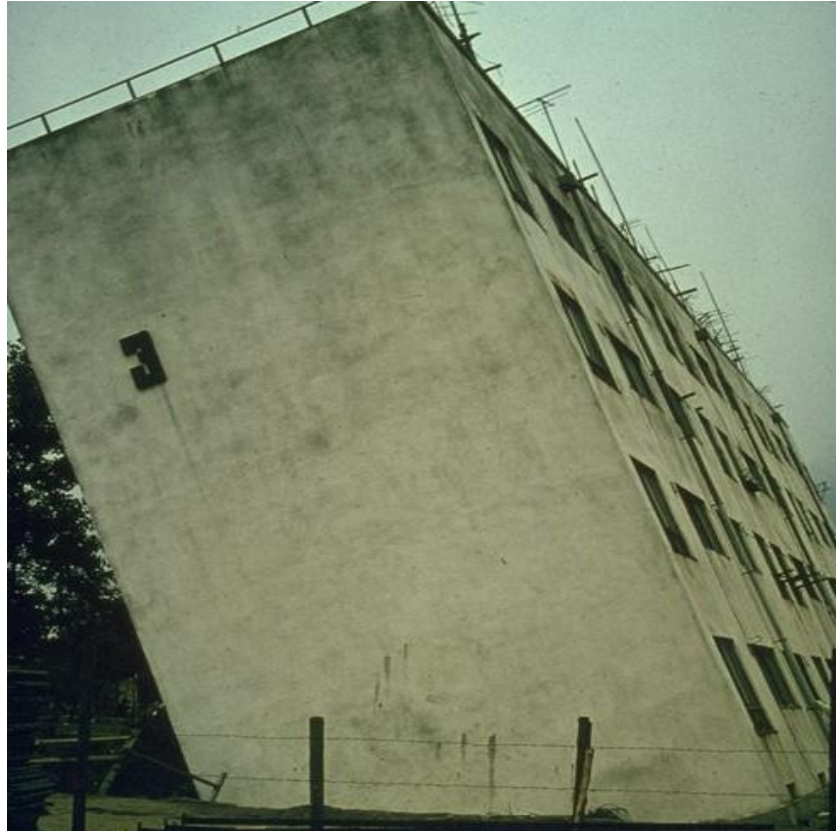
Fig. 2. 85 Edificio inclinado ( http://www.ujaen.es/investiga/rnm217/efectos.htm ).
