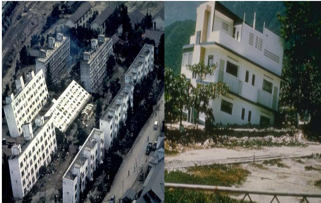
Fig. 2. 88 Efectos de licuefacción (derecha) y asentamientos diferenciales (izquierda) ( http://www.ujaen.es/investiga/rnm217/efectos.htm ).
