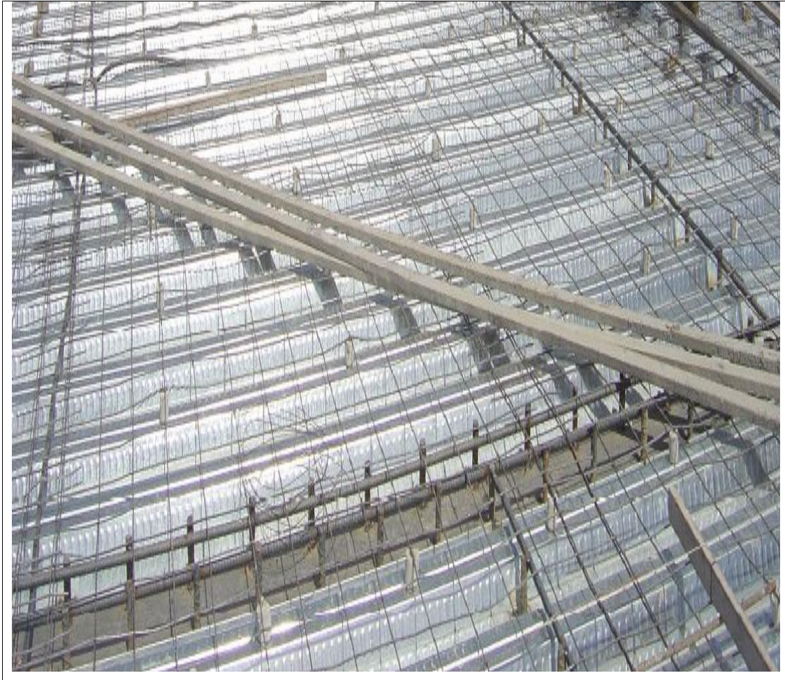
Fig. 2. 43 Empleo de placa metálica para la construcción del sistema de entrepiso.
