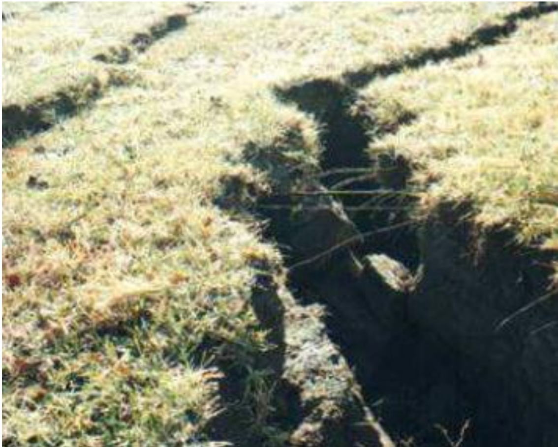
Fig. 2. 98 Formación de grietas en la cabeza del talud de la colonia las Colinas.
