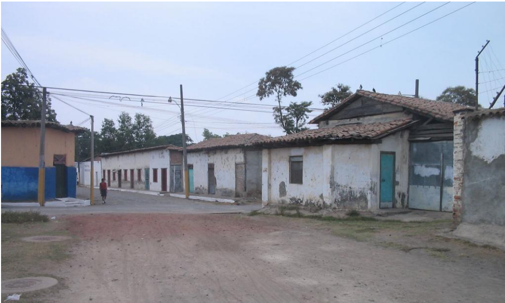
Fig. 2. 25 Viviendas construidas con sistema de paredes estructurales hechas de adobe.
