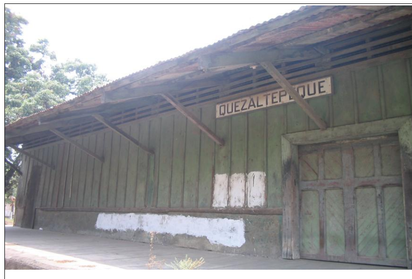
Fig. 2. 3 Edificación hecha con sistema dual de paredes de ladrillo de barro y madera.
