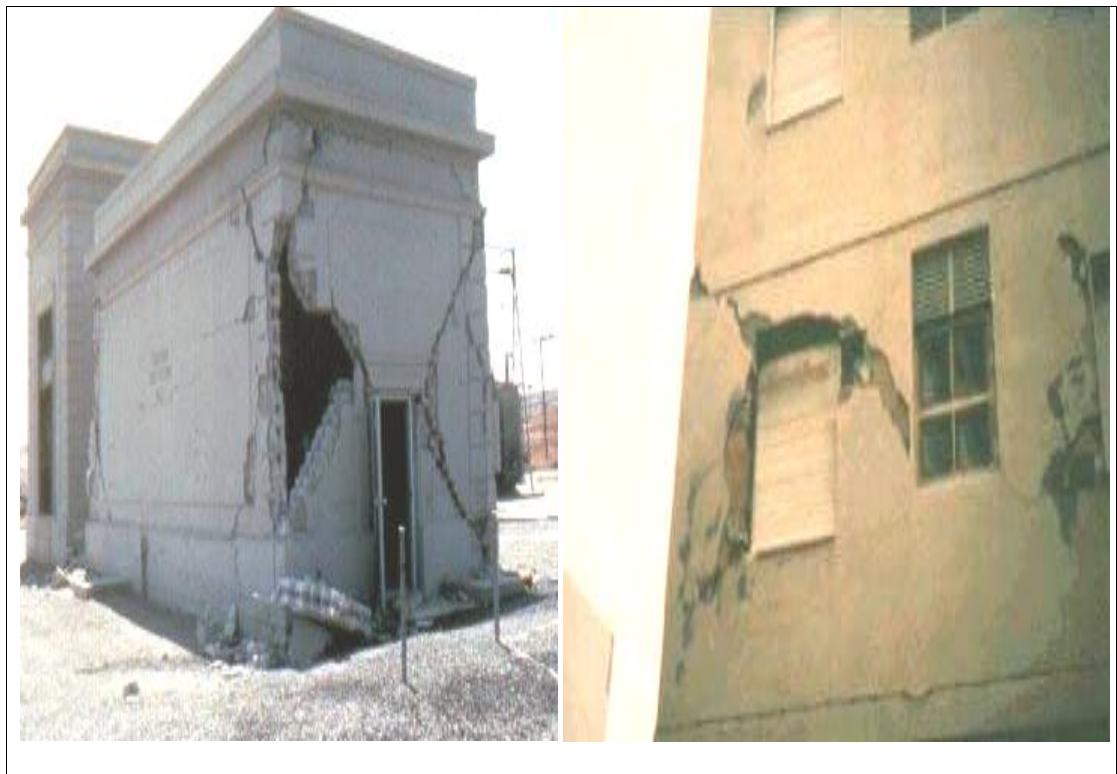
Fig. 2. 35 Fallas por cortante y flexión ( http://www.ugr.es/~iag/inv/cns.html ).
