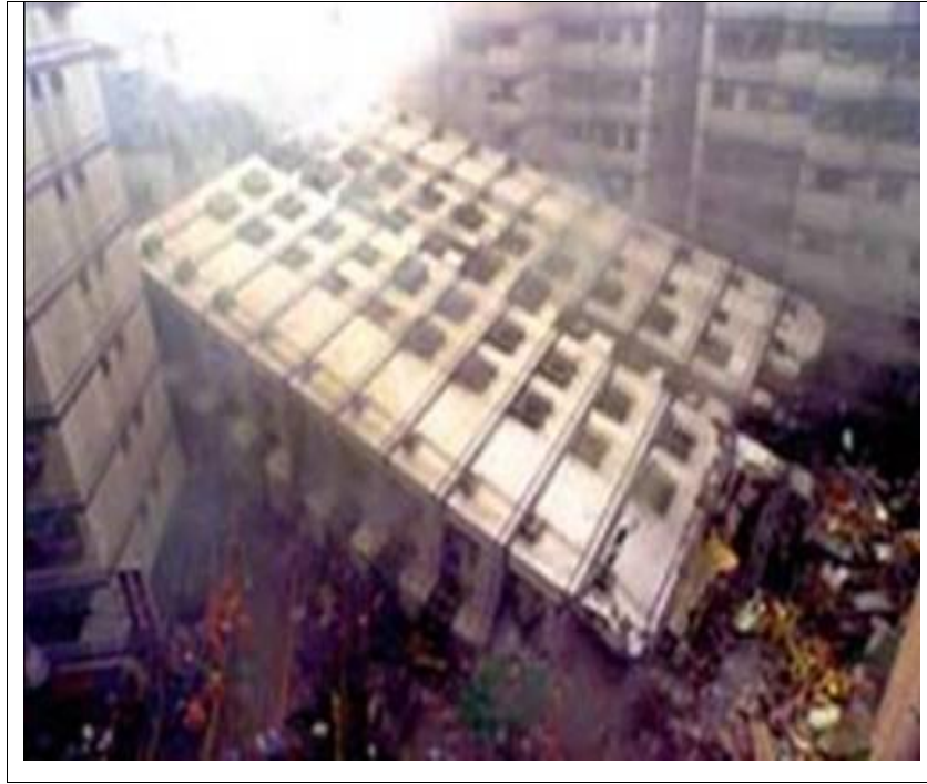
Fig. 2. 87 Edificio colapsado por el efecto de licuefacción producida por un sismo ( http://www.cco.gov.co/tsunami2.htm ).
