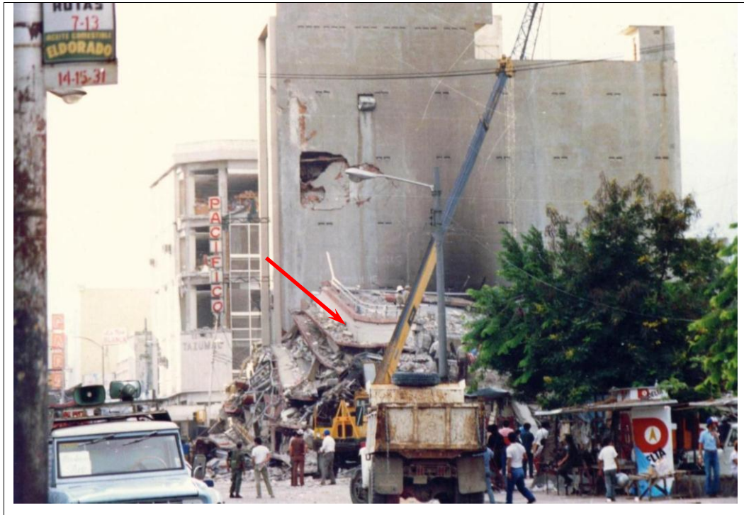
Fig. 2. 82 Colapso total del edificio Rubén Darío (Avalos C., Juan J., 1987).
