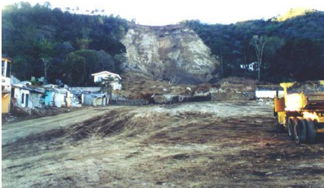
Fig. 2. 97 Falla de talud y movimiento de la masa de suelo sobre la colonia Las Colinas en Santa Tecla, producido por el sismo del 13 de enero del 2001 en nuestro país (Bommer, J. y otros 2001).
