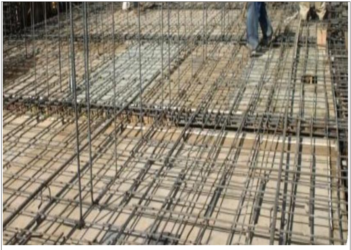
Fig. 2. 44 Sistema de entrepiso de losa densa.
