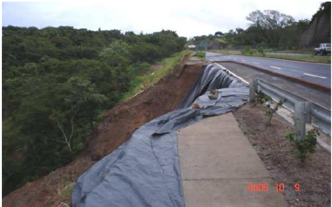
Fig. 2. 110 Colocación de plástico para disminuir la filtración de agua y erosión del talud (Melara, E., 2008).
