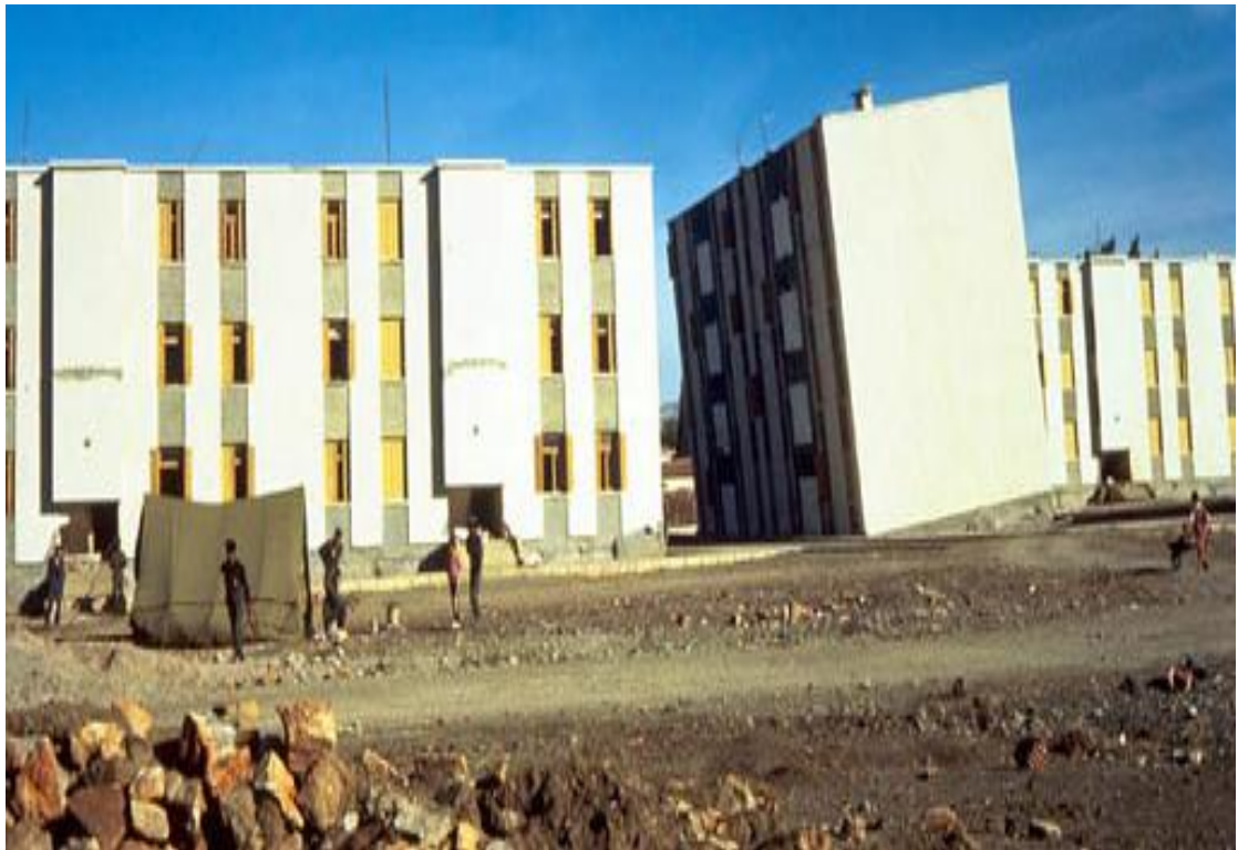
Fig. 2. 84 Inclinación de edificaciones ( http://www.proteccioncivil.org/pefn/gmartin/gmartinind.htm ).
