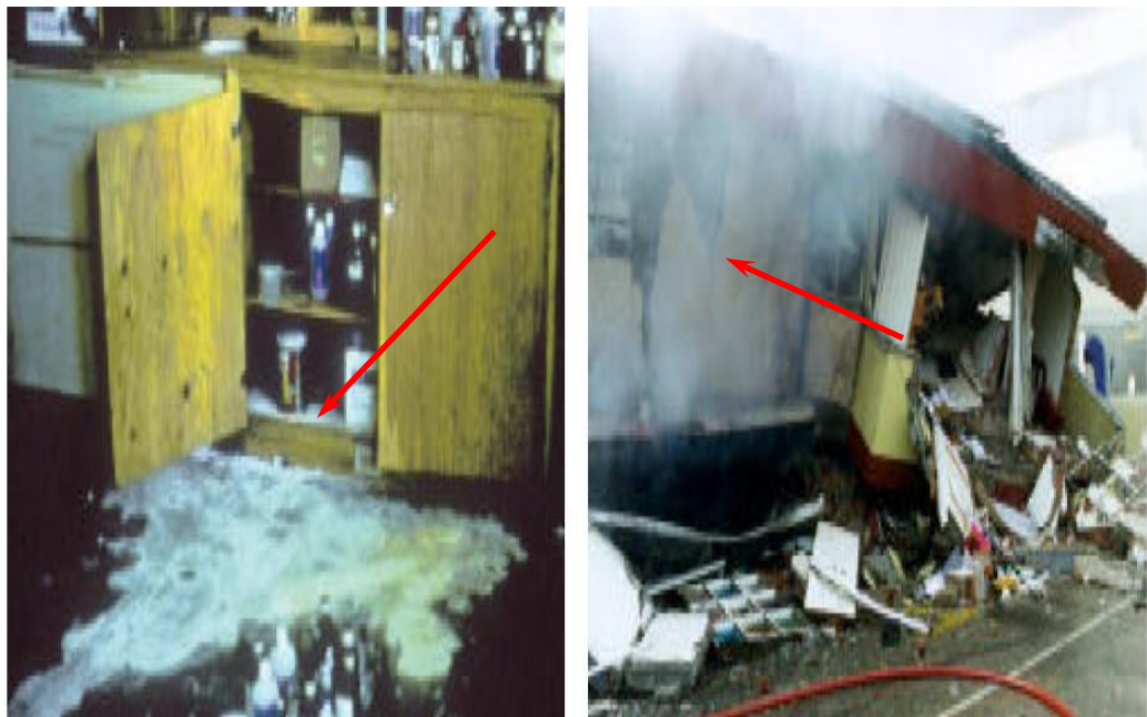
Fig. 2. 77 Daño por el derrame de químicos o sustancias peligrosas (Asociación Colombiana de Ingeniería Sísmica, 2003).
