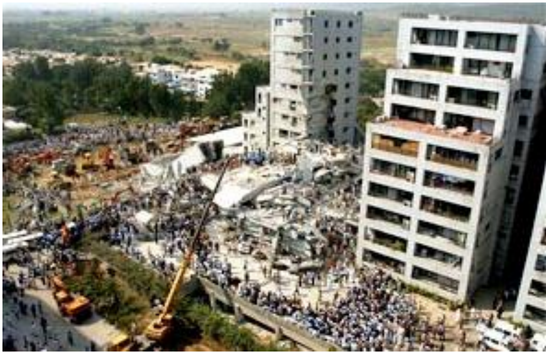
Fig. 2. 81 Colapso total de un edificio ( http://www.clarin.com/diario/2005/10/08/um/sismoap ).
