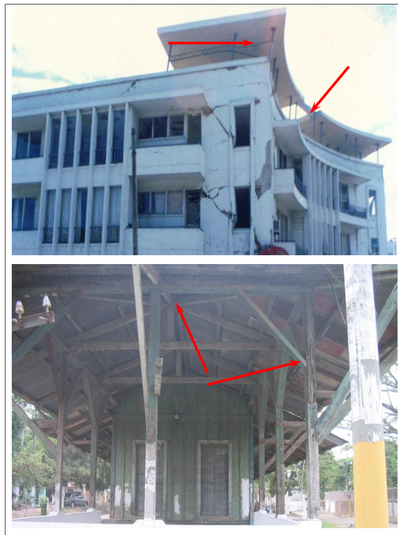
Fig. 2. 72 Ejemplo de una configuración del techo mala (superior) y una regular (inferior).
