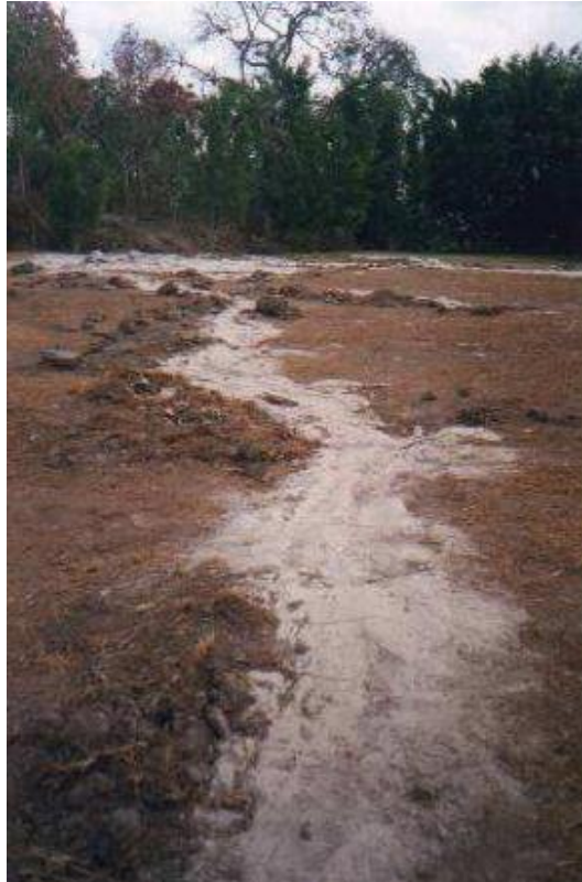
Fig. 2. 111 Sellado de grietas con suelo-cemento (Melara, E., 2008).
