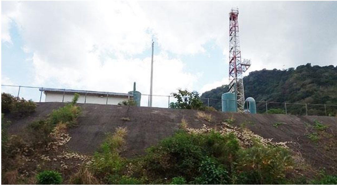
Figura 42 Parte de las instalaciones de la Central Geotérmica de Berlín
