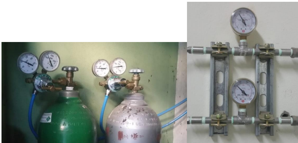
Figura N° 2. Tanques y manómetros de gas oxígeno (verde) y oxígeno ultra puro (gris).
