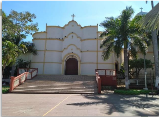
Fotografía 11: Iglesia Parroquial San Simón Apóstol. Fuente: Elaboración Propia.
