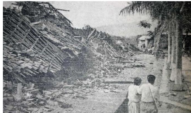
Imagen 2: Derrumbe del portal. Fuente: La Prensa Gráfica
