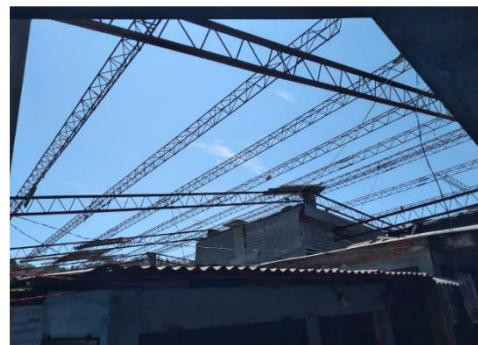
Fotografía 30: Edificación sin finalizar. Fuente: Elaboración Propia.
