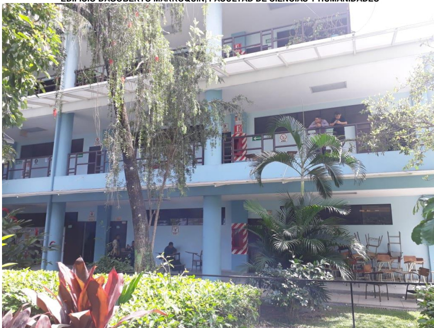
EDIFICIO DAGOBERTO MARROQUÍN, FACULTAD DE CIENCIAS Y HUMANIDADES
