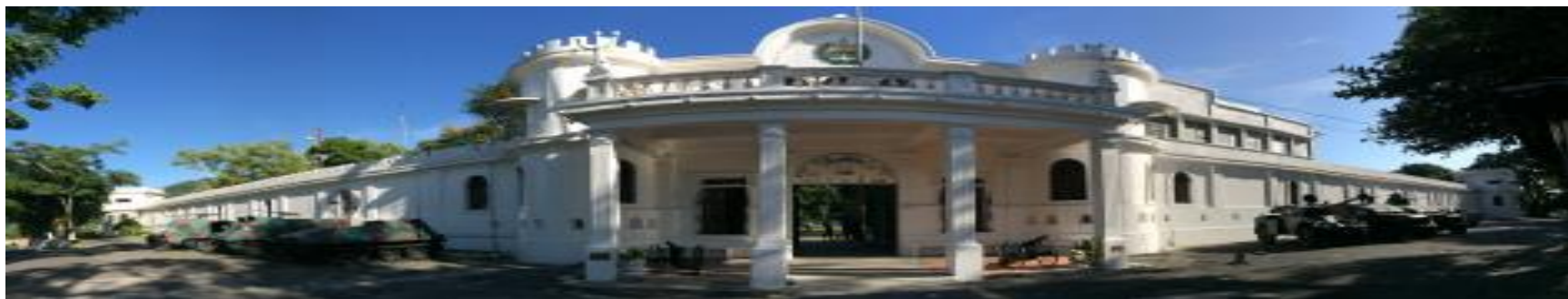
Ilustración 45: Fachada principal panorámica del Museo Militar
