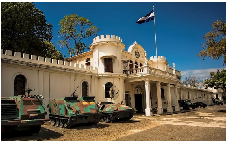
Ilustración 38: Fachada principal del Ex Cuartel El Zapote
