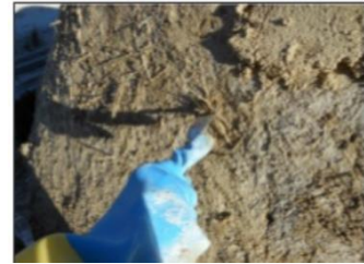
Ilustración 122: Primera capa de revoco con paja.
