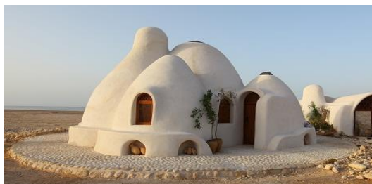
Ilustración 80: Casa construida con técnica de superadobe
