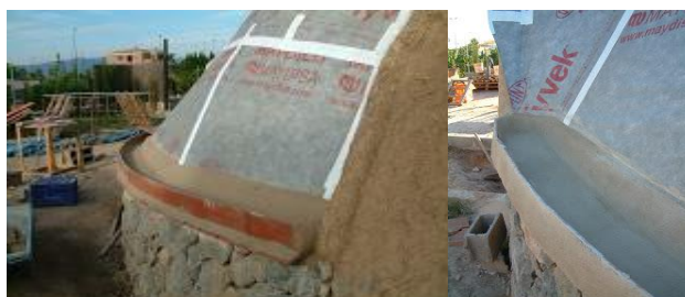
Ilustración 144: Sistema de recogida de agua lluvia de un domo. Fuente: (igludcanyes.blogspot, 2010)
