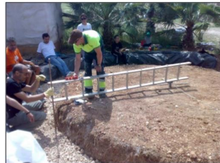
Ilustración 116: Medición del nivel de cimentación.
