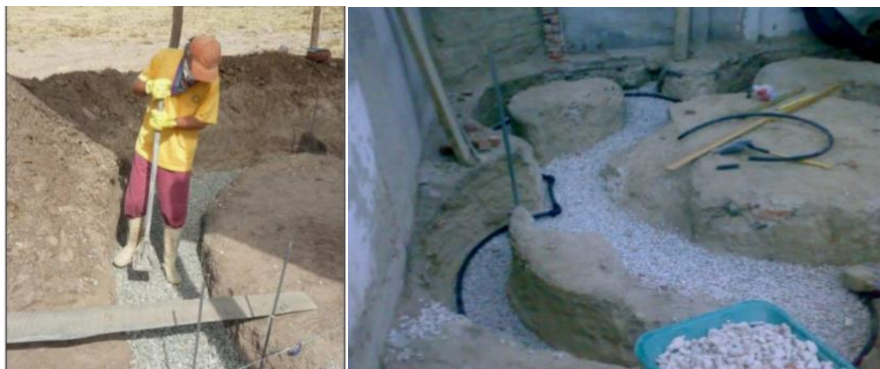
Ilustración 113: Relleno de cimentación con una cama de grava Fuente: (Ciudad, M. 2011)
