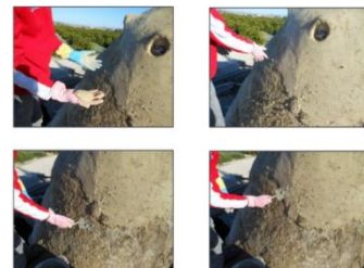
Ilustración 123: Aplicación de la 2da capa de revoco.
