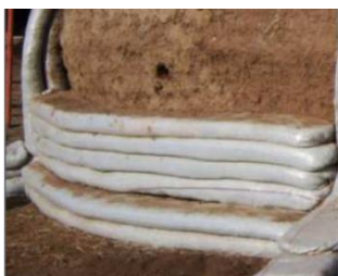
Ilustración 118: Contrafuertes. Fuente: (Ciudad, M. 2011)
