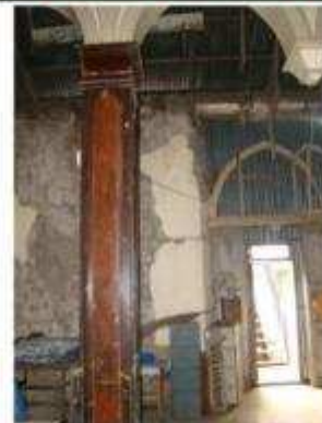
IMAGEN 035 CIELO FALSO DAÑADO
