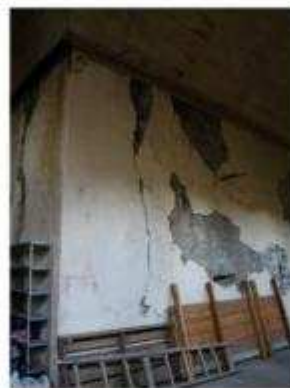
IMAGEN 058 MURO AGRIETADO
