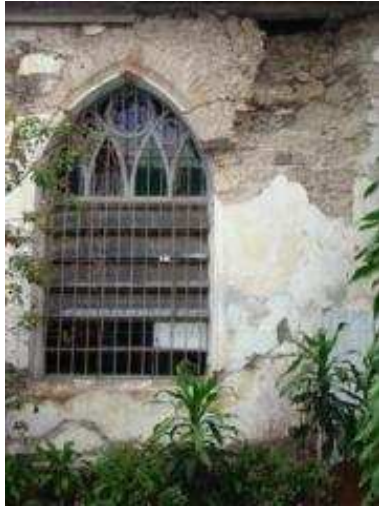
Imagen 50 Aquí podemos apreciar la combinación de dos sistemas constructivos: calicanto y mampostería de ladrillo de obra
