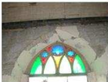
IMAGEN O25 MURO LATERAL REPELLO DAÑADO
