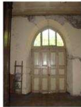
IMAGEN 115 REPELLO DAÑADO
