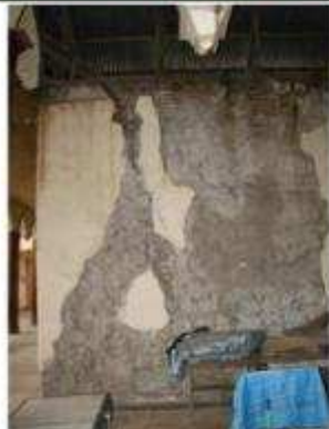
IMAGEN 033 MURO LATERAL REPELLO DAÑADO
