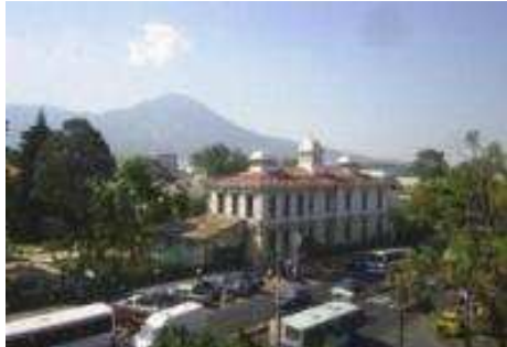
Imagen 18. Hospital Nacional Rosales, un edificio de principios del siglo XX de lámina troquelada importada de Bélgica. Fuente: Fotografía de Walter Zelaya
