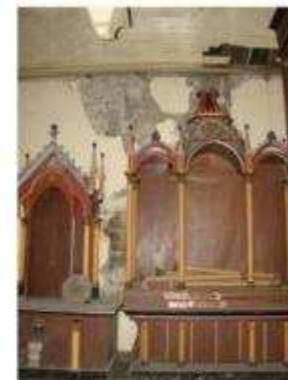
IMAGEN 096 REPELLO COLAPSADO
