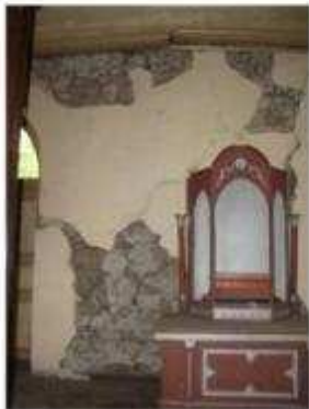
IMAGEN 117 REPELLO DETERIORADO
