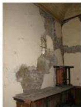
IMAGEN 102 REPELLO DETERIORADO
