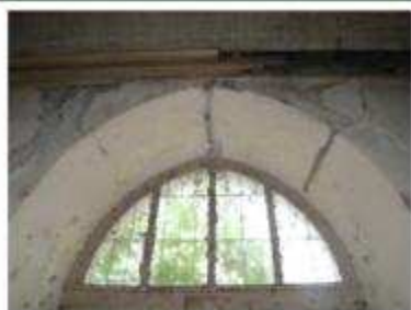
IMAGEN 017 MURO LATERAL REPELLO DAÑADO
