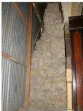
IMAGEN 109 PARED COLAPSADO
