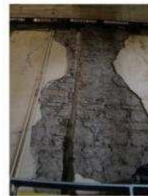
IMAGEN 056 REPELLO DAÑADO
