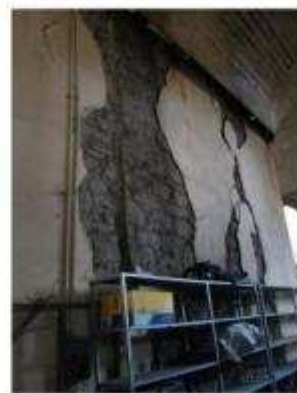
IMAGEN 055 REPELLO DAÑADO
