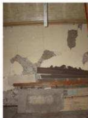
IMAGEN 091 REPELLO DETERIORADO
