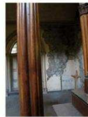
IMAGEN 064 REPELO COLAPSADO
