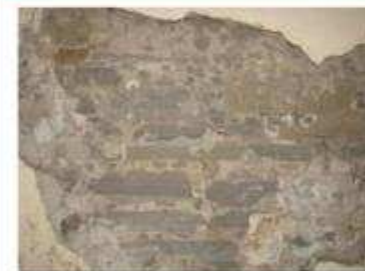
IMAGEN 076 REPELLO COLAPSADO
