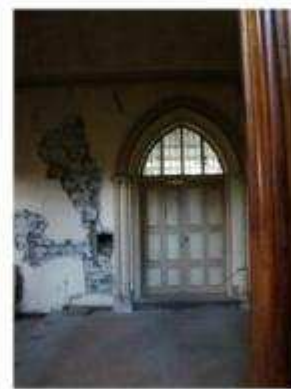
IMAGEN 063 REPELO DETERIORADO
