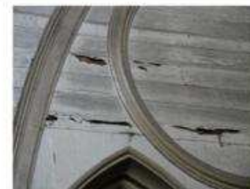
IMAGEN O68 REPELLO COLAPSADO
