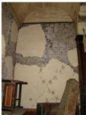
IMAGEN 0105 REPELLO DETERIORADO
