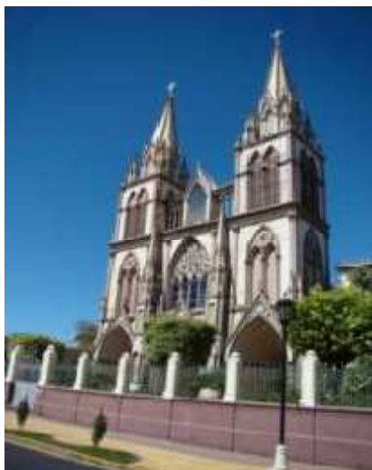
Imagen 53 fachada de Iglesia El Carmen. Sistema constructivo de lámina de zinc y madera Fotografía: Carlo Morán
