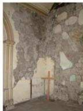
IMAGEN O67 REPELLO DAÑADO
