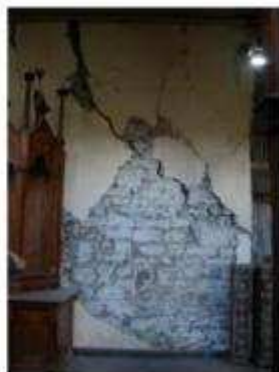
IMAGEN 122 PARED COLAPSADA
