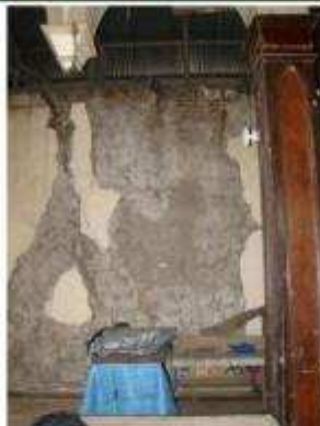
IMAGEN 034 MOLDURAS DE CIELO FALSO DAÑADO
