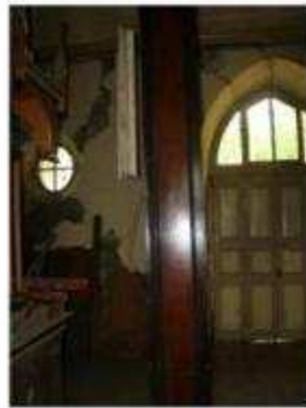
IMAGEN 114 REPELLO DAÑADO
