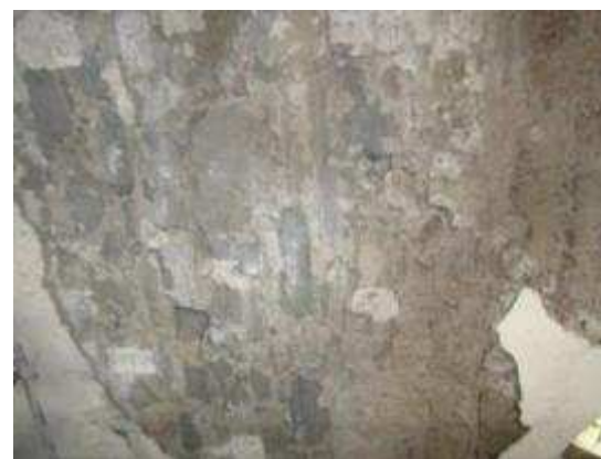
Imagen 49. Pared sin repello que muestra el sistema constructivo de calicanto de las paredes perimetrales del templo
