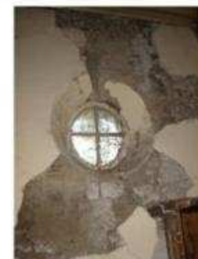
IMAGEN 104 REPELLO COLAPSADO
