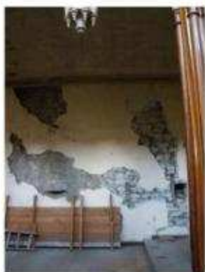
IMAGEN 061 REPELO DAÑADO
