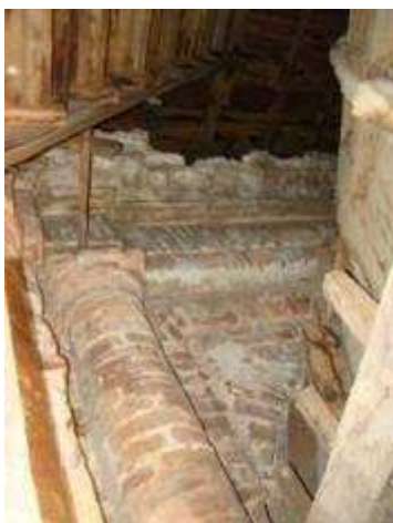
Imagen 48. Primera fachada de la Iglesia El Carmen en su ubicación actual de mampostería de ladrillo y mortero que está ubicada dentro de la fachada de lámina y madera de la posterior edificación.
