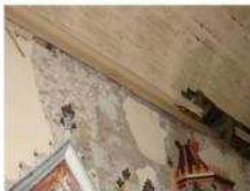
IMAGEN 090 REPELLO DETERIORADO
