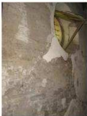
IMAGEN 077 REPELLO COLAPSADO
