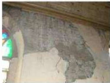
IMAGEN 009 MURO LATERAL REPELLO DAÑADO
