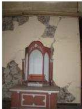
IMAGEN 118 REPELLO DETERIORADO
