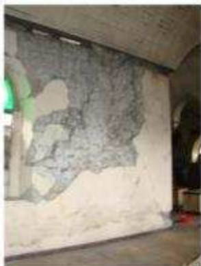
IMAGEN 033 MURO LATERAL REPELLO DAÑADO
