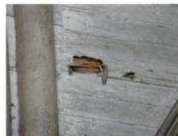
IMAGEN O67 REPELLO DAÑADO
