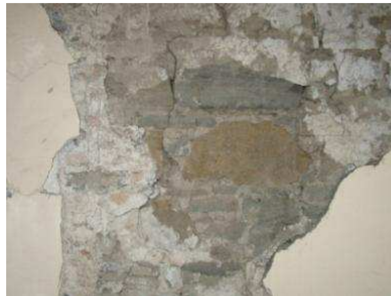
Imagen 46. Detalle de sistema constructivo de los cerramientos de la Iglesia El Carmen Fotografía: Carlo Moran
