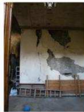
IMAGEN 059 REPELOS DAÑADOS
