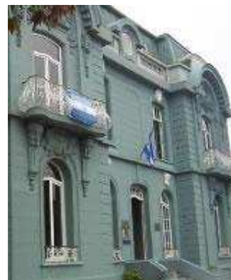
Imagen 17. Casa Dueñas fiel ejemplo del sistema constructivo europeo conocido como "Deployer". Fuente: Fundación CLIC de El Salvador
