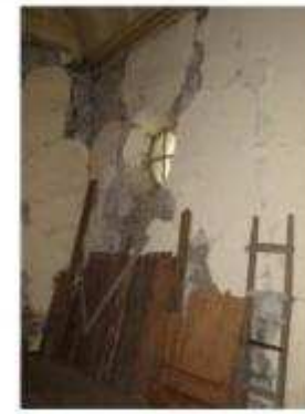
IMAGEN 112 REPELLO DETERIORADO
