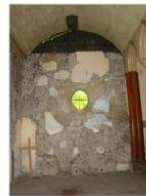
IMAGEN O68 REPELLO COLAPSADO
