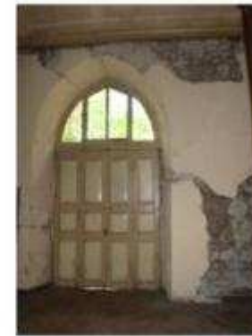
IMAGEN 116 REPELLO DAÑADO
