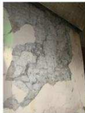
IMAGEN O27 REPELLOS DETERIORADOS
