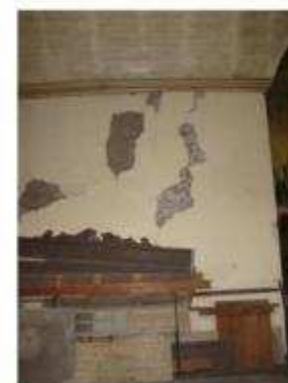
IMAGEN 092 REPELLO DETERIORADO
