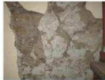
IMAGEN 115 REPELLO DAÑADO
