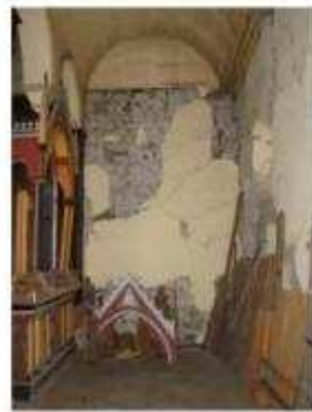
IMAGEN 111 REPELLO DETERIORADO
