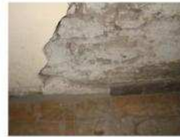
IMAGEN 116 REPELLO DAÑADO
