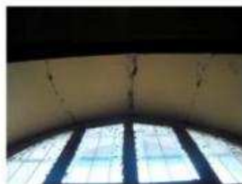
IMAGEN 097 PUERTA Y REPELLO DETERIORADO
