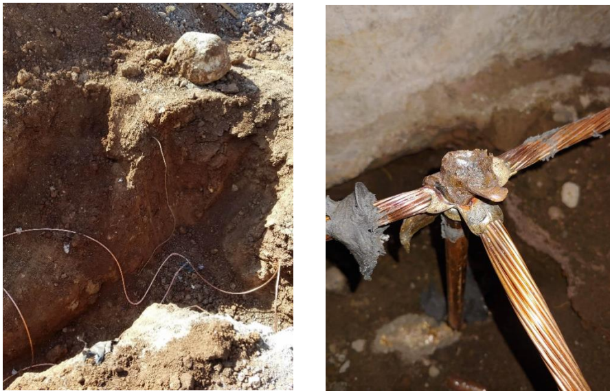
Figura 30: Soldadura exotérmica para red de tierra
