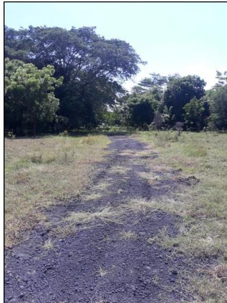
Figura 1.2 Tratamiento típico de Balastro utilizada como capa de rodadura en caminos rurales
