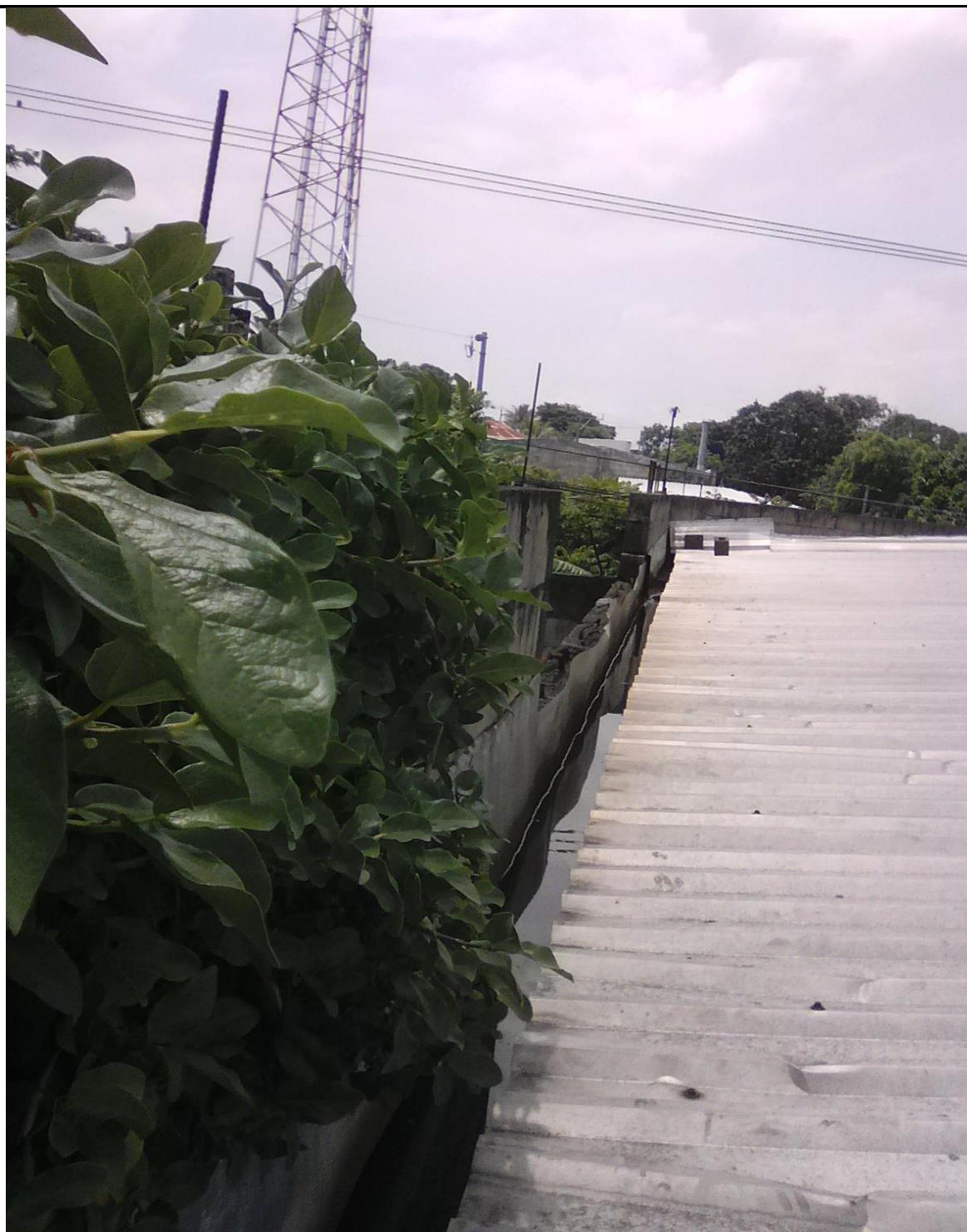
VISTA DEL EMPOZAMIENTO DE AGUAS LLUVIAS DEL CANAL DEL TECHO
