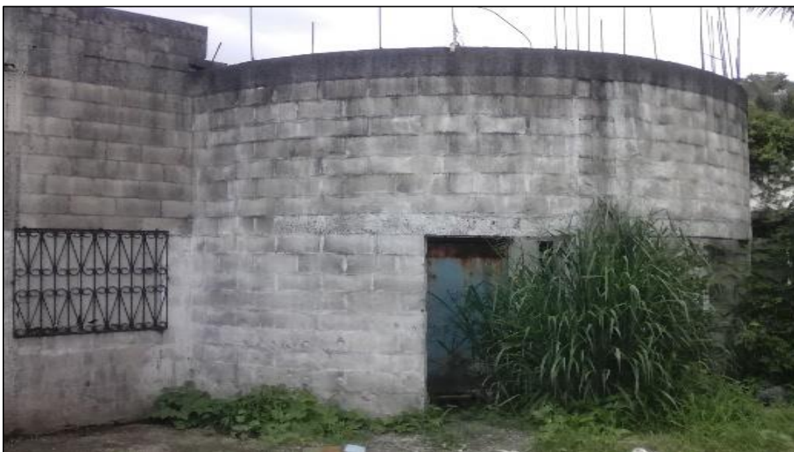
Figura 4-10 Condición actual vista fachada principal. Fuente: Elaboración propia
