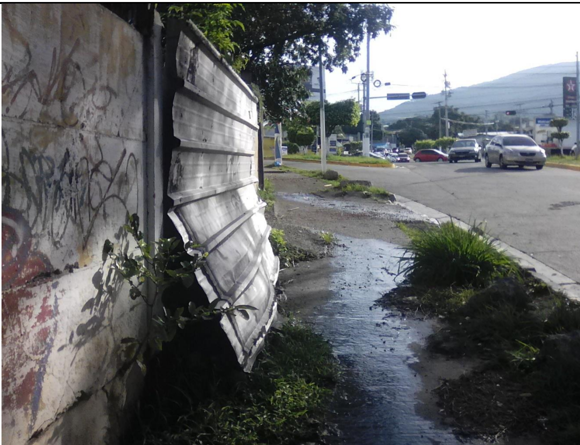
OTRA VISTA HACIA EL PONIENTE DEL TAPIAL PREFABRICADO LINDERO NORTE.
