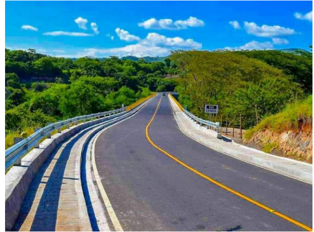
Puente sobre Río Lempa Fotografía: Mapio.net
