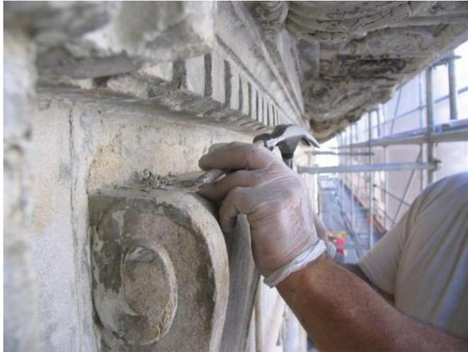
Figura FI-07: Limpieza de capas de pintura dañadas. Fuente: <https://moguerza.com>
