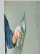
**3: Aplicar capa de impermeabilizante:** aplíquese capa de pintura impermeabilizante sobre las paredes intervenidas, al final aplicar capa de pintura que coincida con la del templo.
