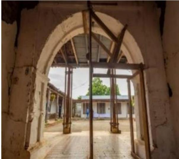
Figura FI-03: Refuerzo de arco de entrada Casa Barrientos, Izalco.
