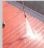
**2. Aplicar:** aplicar tratamiento antioxidante sobre superficie, de ser necesario reemplazar lamina si el daño excede a la pérdida de pintura,
