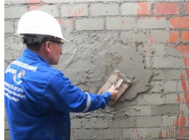
Figura FI-01: aplicación de repello sobre paredes. Fuente: <https://constructivo.com>
