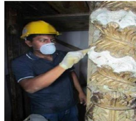
Figura FI-02: aplicación de material adhesivo. Fuente: MUNA
