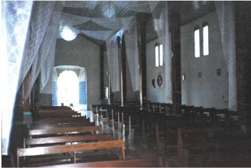
Vista de Nave Central la cual posee dos filas de columnas de madera que soportan la estructura de la cubierta.
