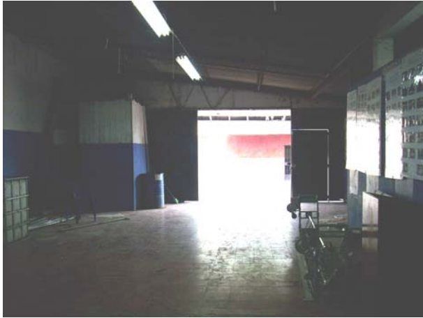
Interior de Casa Comunal (Foto-A08)
