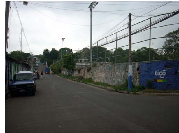
Fachada sur de área deportiva (Foto-DO3)
