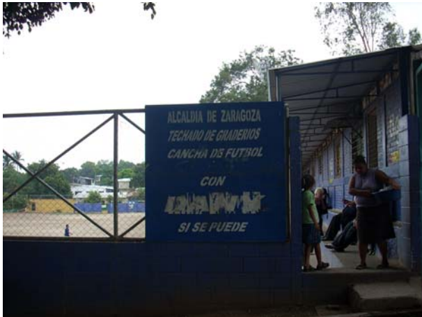
Acceso sobre avenida España sur (Foto-DO1)
