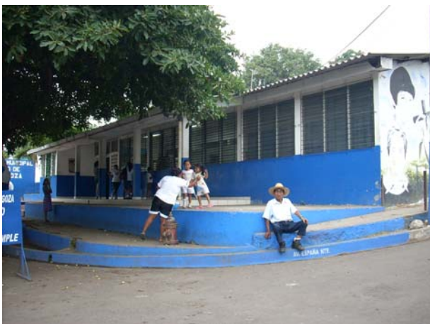
Fachada Principal de Alcaldía de Zaragoza (Foto-A01)
