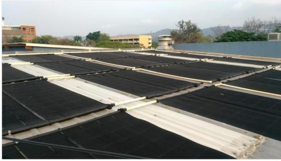
A) Captadores solares de polipropileno.
