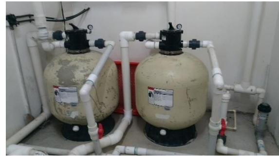
D) Sistema de filtración de arena.
