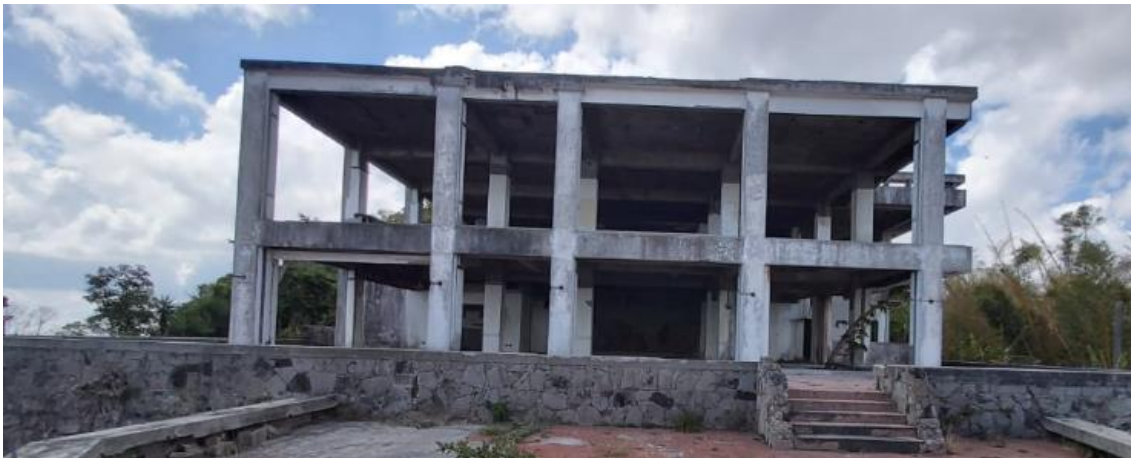
Ilustración 20 Vistas desde la instalación del ex teleférico y su estructura
