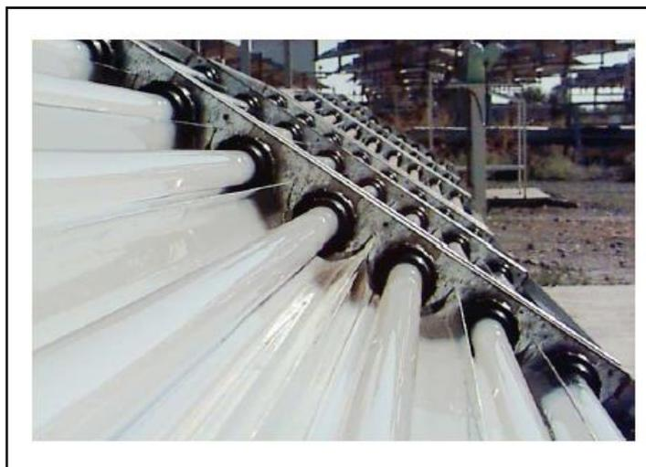
**Figura 2. 25 Detalle de un colector CPC donde se observa la configuración de los tubos reactores.**
