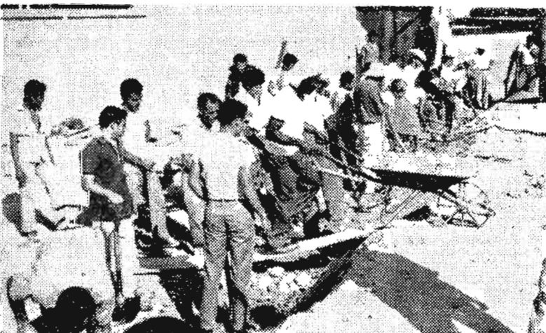
EN PLENA LABOR. —Con entusiasmo los voluntarios reanudaron el domingo anterior los trabajos de construcción pro Ciudad Universitaria. Aquí apreciamos a un grupo de ellos manejando carretillas.
