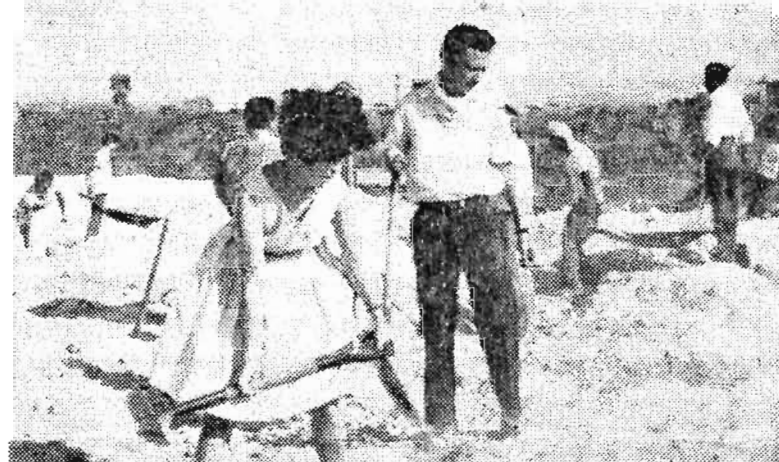
TRABAJOS DE JARDINERIA. —Una señorita, pala en mano, trabaja en obras de jardinería en terrenos del edificio del Departamento de Ciencias Biológicas. Son muchas las mujeres que participan en estos trabajos voluntarios.
