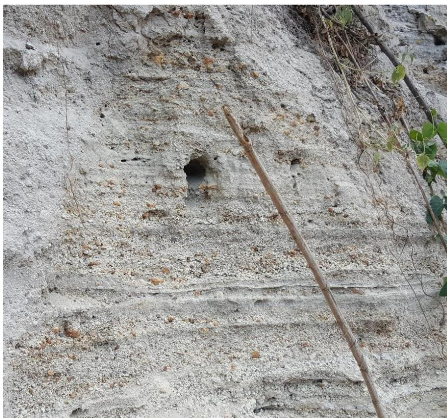
*Figura No. 4.24: Representación del material que conforma el talud del punto Lago de Ilopango Punto 2
