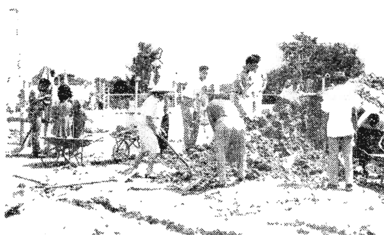
PRIMER ANIVERSARIO DE TRABAJOS VOLUNTARIOS.—La gráfica recoge el instante en que un grupo de trabajadores voluntarios laboran en terrenos de la Ciudad Universitaria. Esta contribución del pueblo hacia su Universidad se inició el 28 de abril de 1963. Durante este primer año la labor ha sido positiva. Se han realizado trabajos de embellecimiento, de terracería, construcción de aceras, cunetas, etc. Una vez más se ha puesto de manifiesto el espíritu de cooperación ciudadana hacia la Universidad.
