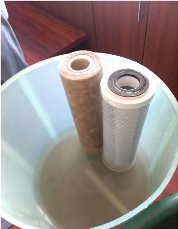
Fotografía 5: cambio de filtro de oasis donde toman agua los empleados.
