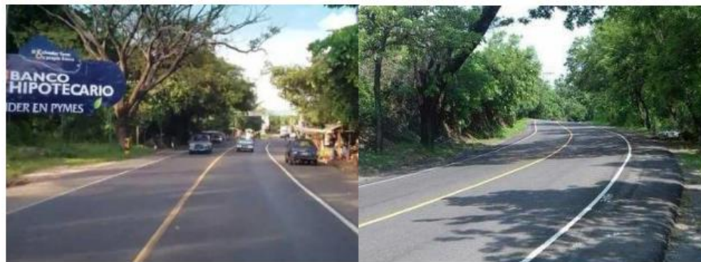
Figura 3.29 Pavimento Flexible CA02E Dv. Aeropuerto El Salvador – Zacatecoluca.
