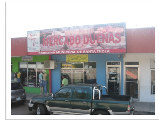
Puestos perimetrales exteriores
