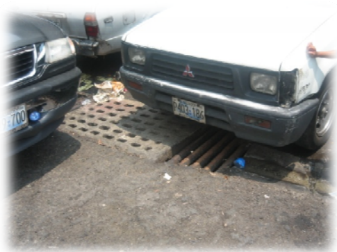
Tragante ubicado en el estacionamiento del mercado
