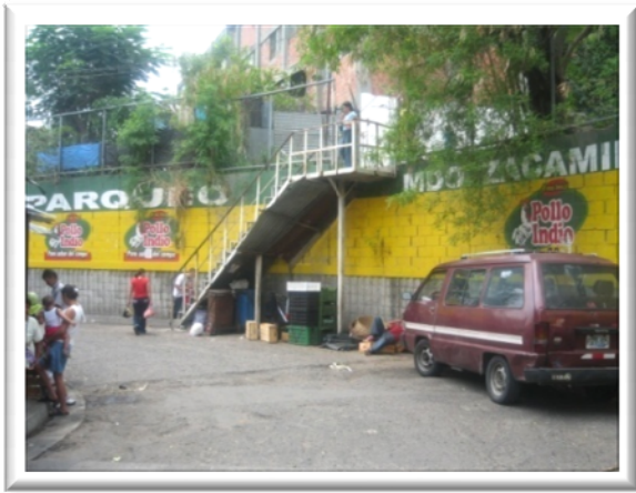
Esquina Norponiente del terreno (Mojón 4) Nivel a 3.60 m.
