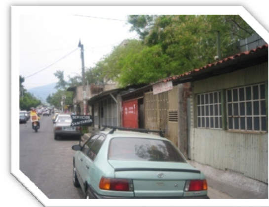
Servicios sanitarios públicos
