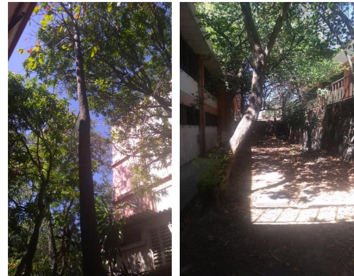
Imagen 10 presentación de vegetación en las fachadas Norte y Fachada Oriente
