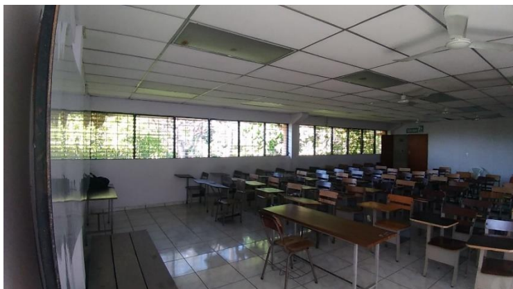
Imagen 69 Ventanas Fachada Sur utilizada en aulas 2o Nivel
