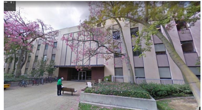
Imagen 36: fachadas de edificio Fuente: Google
