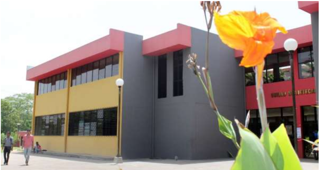
Figura 6-13 Edificio donde se encuentra instalado el medidor M3.
