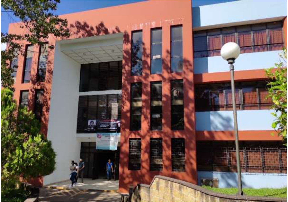
Figura 6-7 Edificio donde se encuentra instalado el medidor M2.
