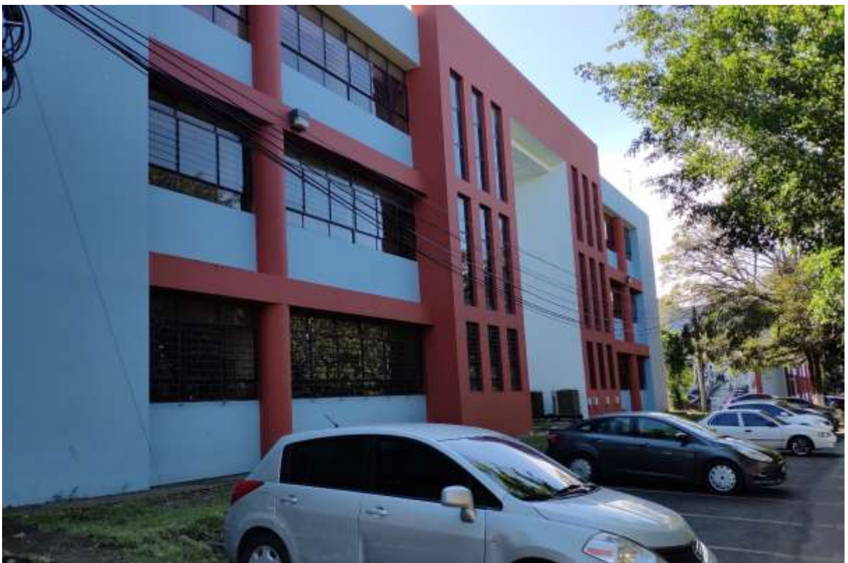
Figura 6-8 Edificio donde se encuentra instalado el medidor M2.
