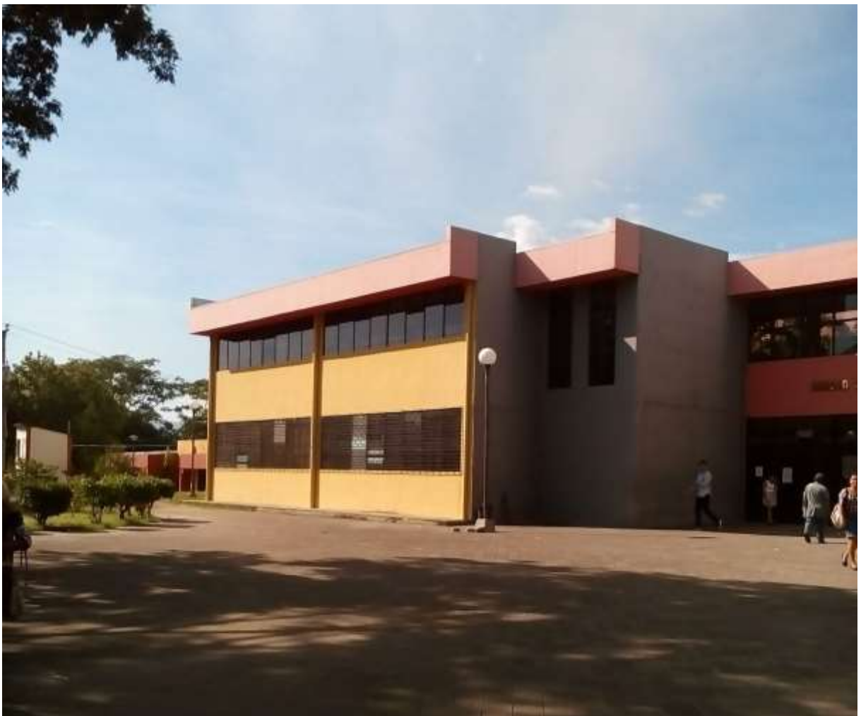
Figura 6-14 Edificio donde se encuentra instalado el medidor M3.
