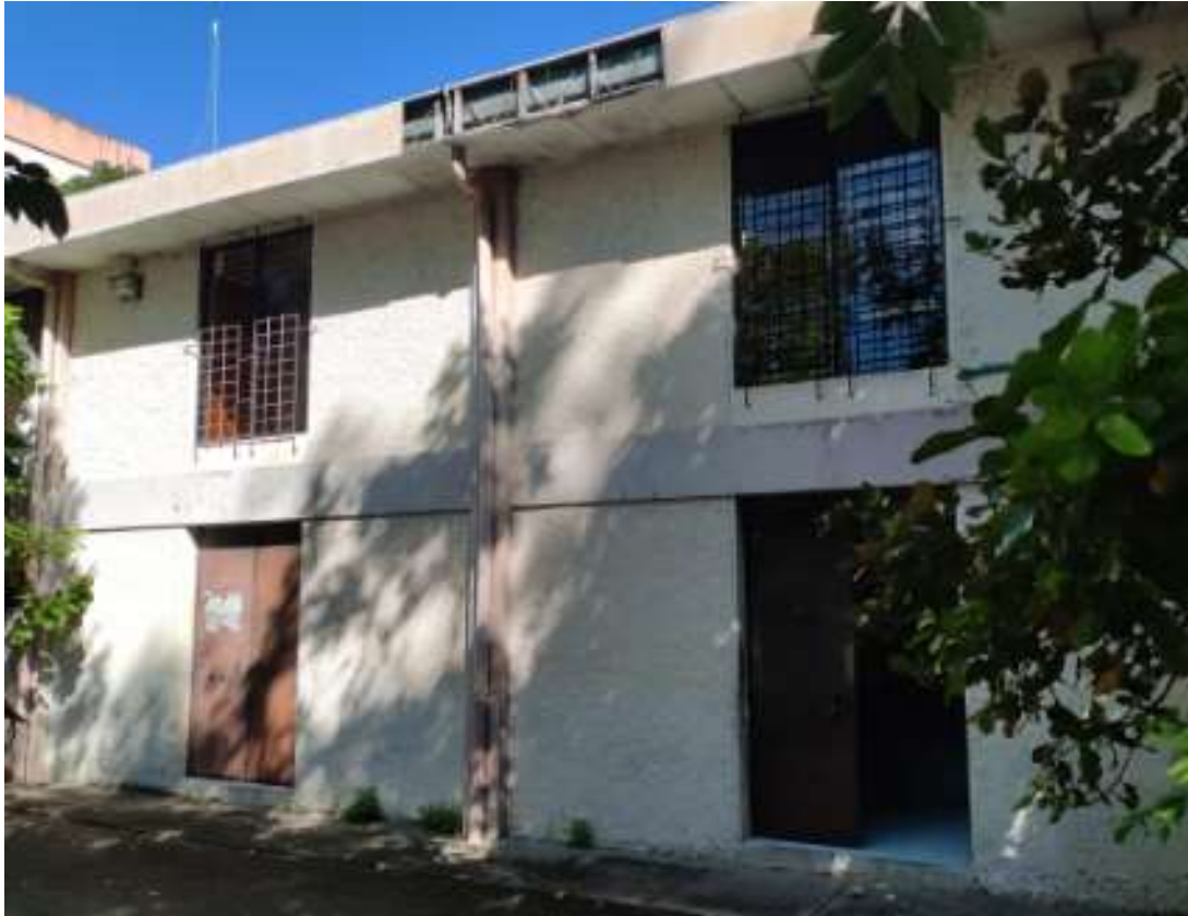
Figura 6-2 Edificio donde se encuentra instalado el medidor M1.
