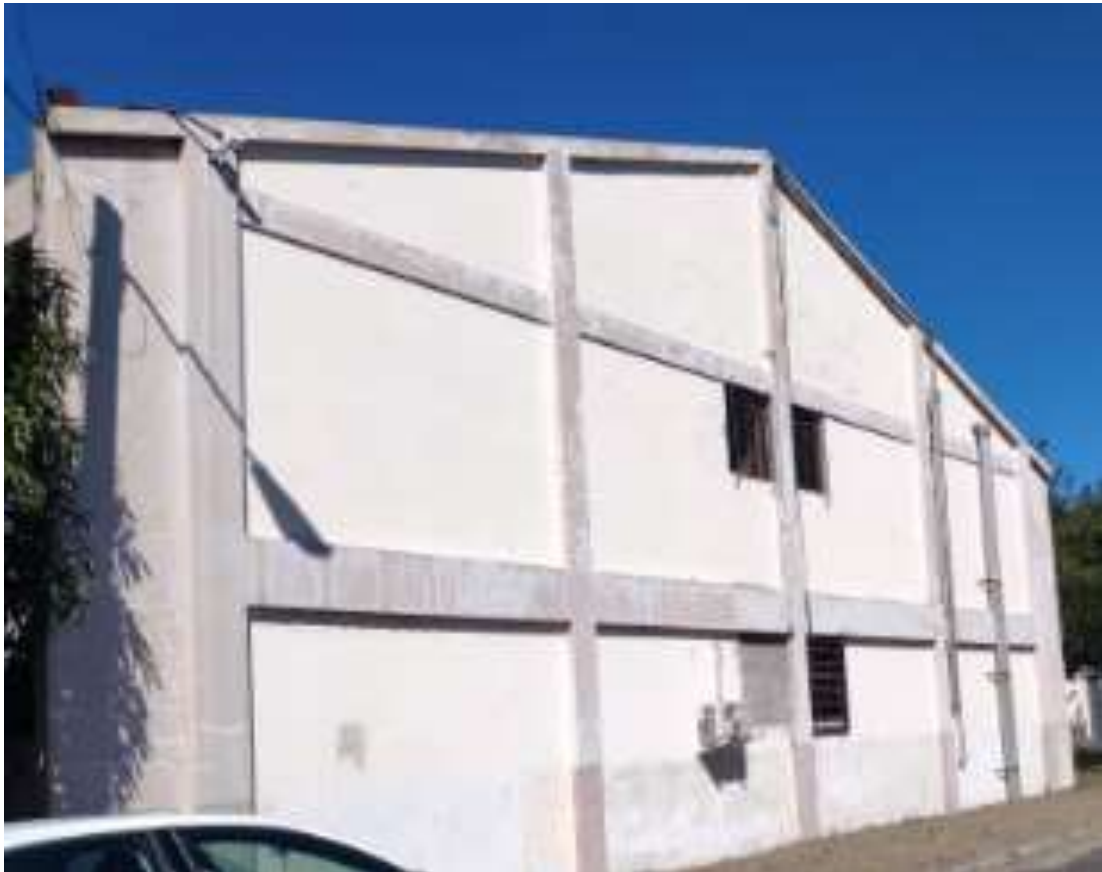
Figura 6-3 Edificio donde se encuentra instalado el medidor M1.
