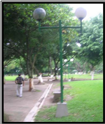
Alumbrado interno del parque
