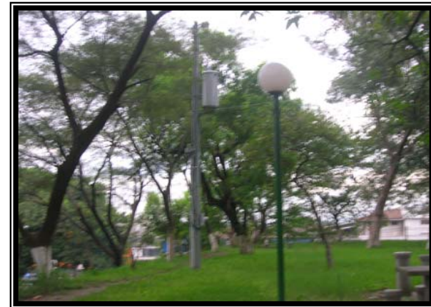
Tendido eléctrico dentro del parque
