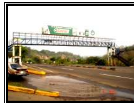
Pasarela ubicada en el desvío a la ciudad de Armenia
