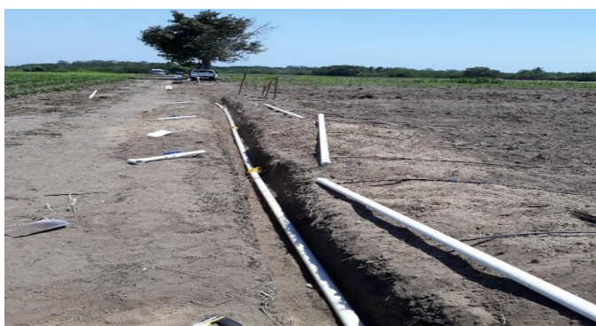
Figura A-1: Instalación de vena central o conexión madre para poder distribuir los laterales de riego con cada válvula de paso.
