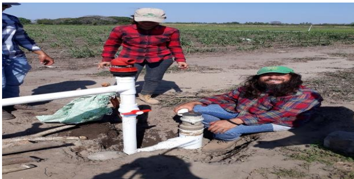
Figura A-3: Instalación de sistema de riego por goteo, calibración de manómetros y limpieza de filtro.
