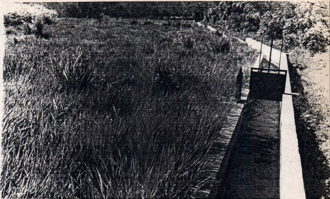
Compuerta CR-1 y compuerta derivadora hacia canal secundario
