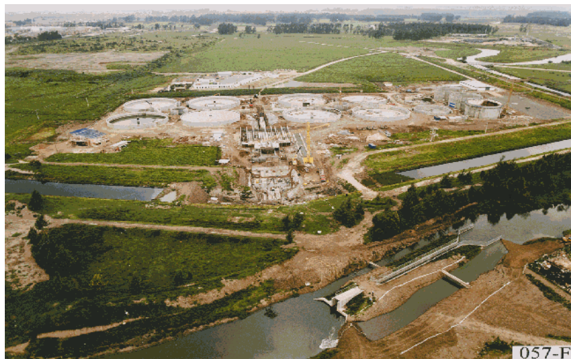
Figura 2.9: Vista Panorámica de la Planta de Tratamiento del Salitre
