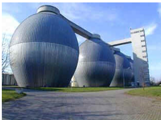
Figura 4.11: Esquema de un tanque de digestión anaerobia.
