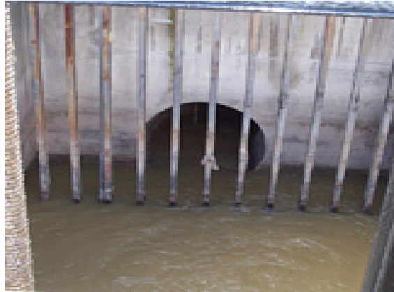
Figura 4.1: Esquema de una rejilla de limpieza manual.
