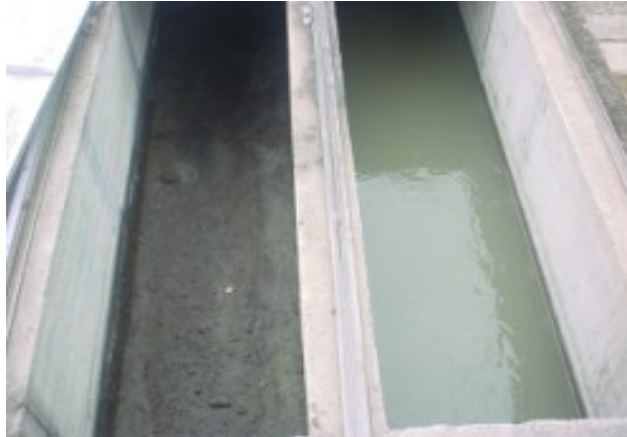
Figura 4.2: Esquema de un desarenador de sección horizontal.
