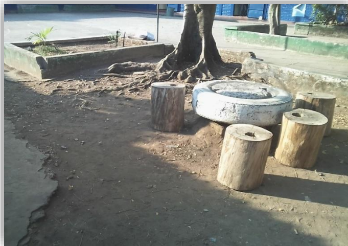
Fotografía N7: Espacio para esparcimiento en mal estado. Fuente: Fotografía tomada por grupo de trabajo.
