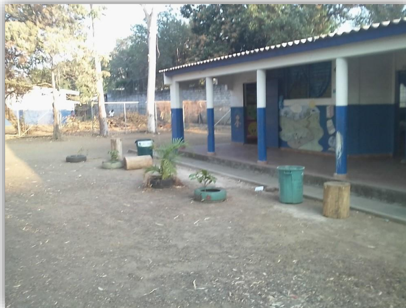
Fotografía 11: Espacio para esparcimiento inexistente. Fuente: Fotografía tomada por grupo de trabajo.
