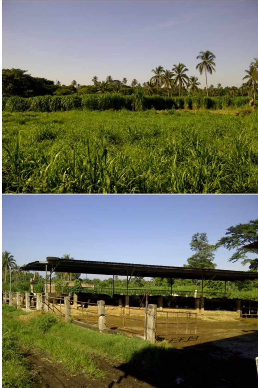
Figura 28 Ubicación del biodigestor
