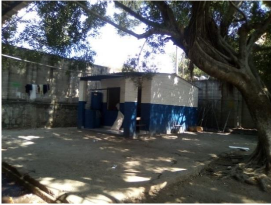
Cocina del Centro Escolar
