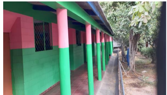
Aulas del centro Escolar de Área de primer ciclo
