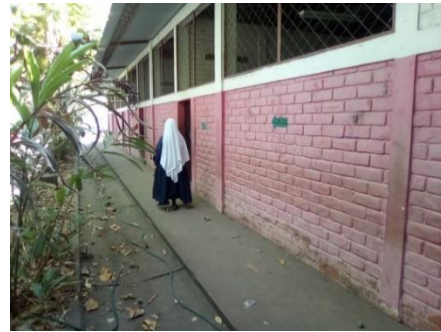
Primer pabellón del costado Izquierdo de aulas por parte de atrás.
