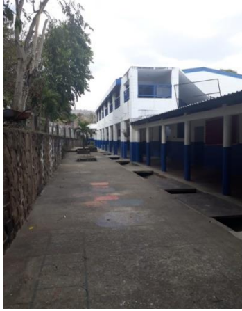
Aulas de la primera planta y segunda planta del Centro Escolar
