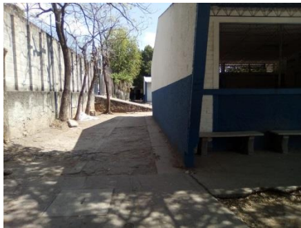
Primer pabellón de aulas costado derecho
