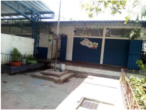
Pabellón de aulas costado derecho del Centro Escolar
