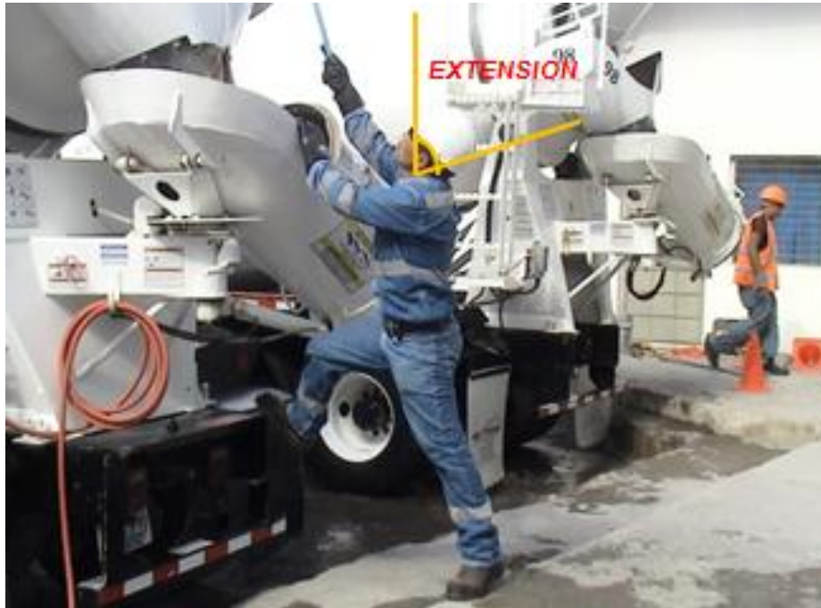
Figura N°32 Limpieza final de equipo para operador de mixer
