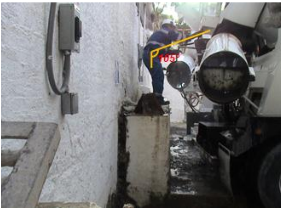
Figura N°33 Limpieza final de equipo para operador de mixer
