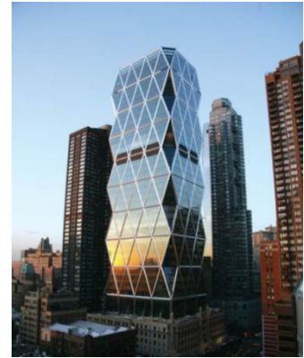
Primer edificio con certificación Leed Gold, Hearst Tower, Manhattan.
